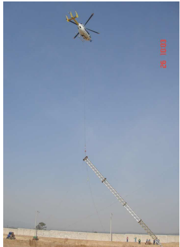
Figura 49. Columna pivoteada sobre su base con helicóptero.
