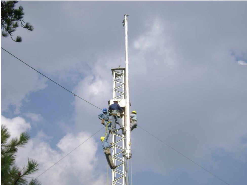
Figura 78. Armado de la T-49 con la pluma deslizante
