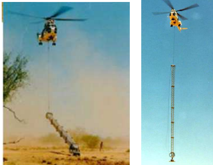
Figura 50. Armada en otro sitio, pivoteada y transportada con helicóptero al punto de uso.
