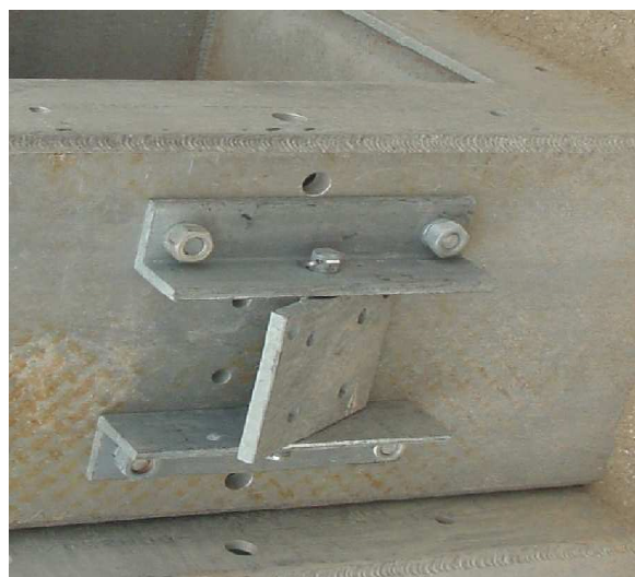
Figura 6. Accesorio adaptador para aislador tipo poste (cantiliever)
