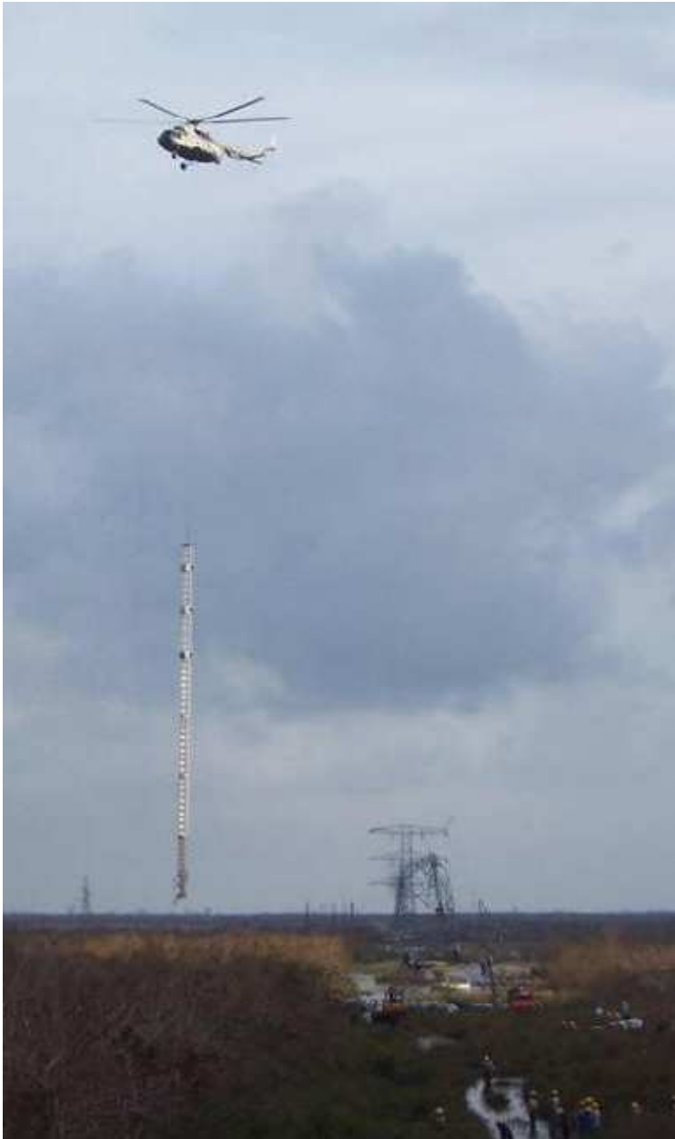
Figura 51. Armada en otro sitio, pivoteada y transportada con helicóptero al punto de uso.
