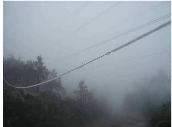
Figura 68. Vista de la T-46 dañada a causa de la nevada en la zona del Ajusco, del lado derecho se puede apreciar el espesor que alcanzó el hielo sobre el hilo de guarda.
