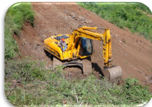
Figura 97. Habilitación de camino de un acceso
