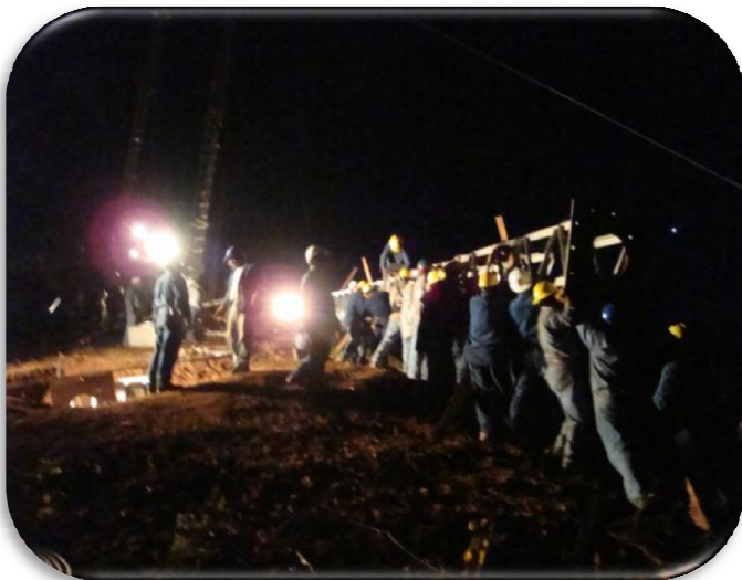
Figura 115. Izaje de la segunda columna de la estructura de emergencia
