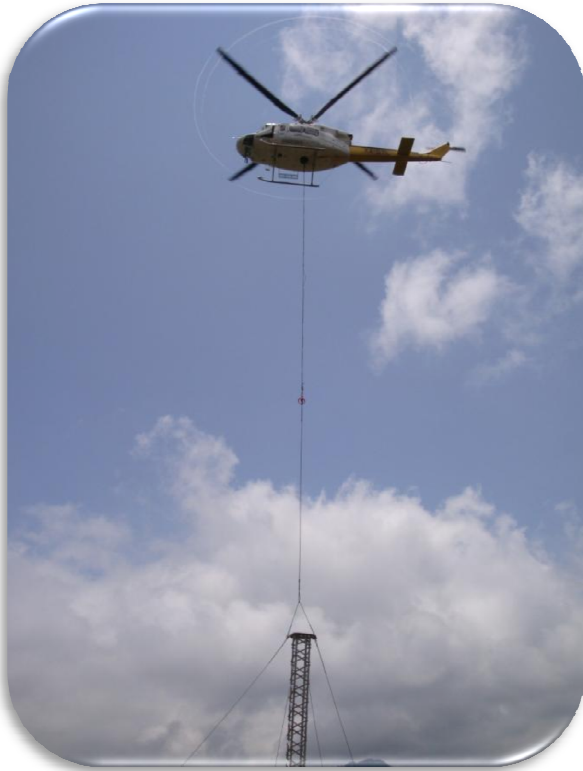
Figura 111. Izaje de la primera columna de la estructura de emergencia con apoyo del helicóptero.
