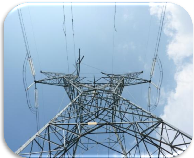
Figura 93. Anclaje de conductores de la fase central a la ventana de la estructura
