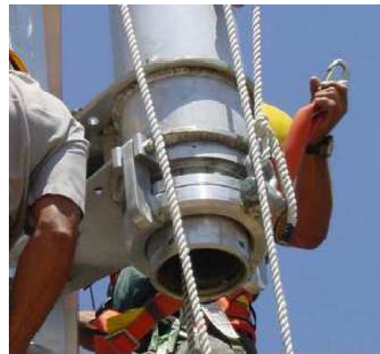
Figura 66. Colocación y aseguramiento del deslizador, para subir la pluma.
