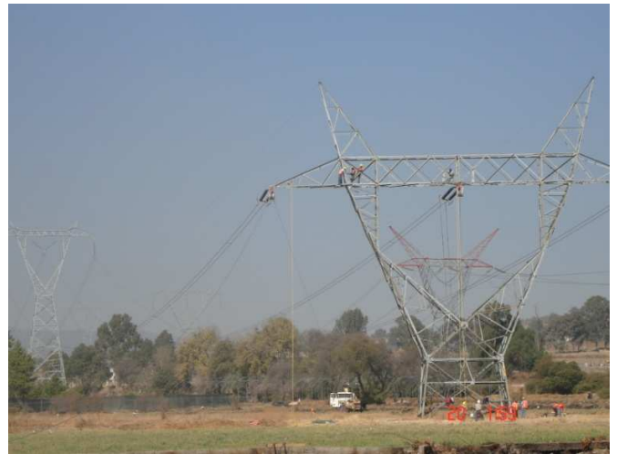
Figura 127. Instalación de retenidas en T-65
