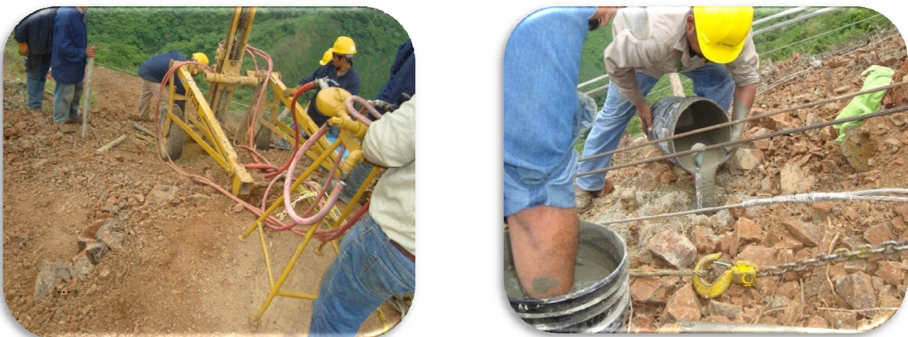
Figura 106. Perforación de barreno para anclas tipo mantarraya
