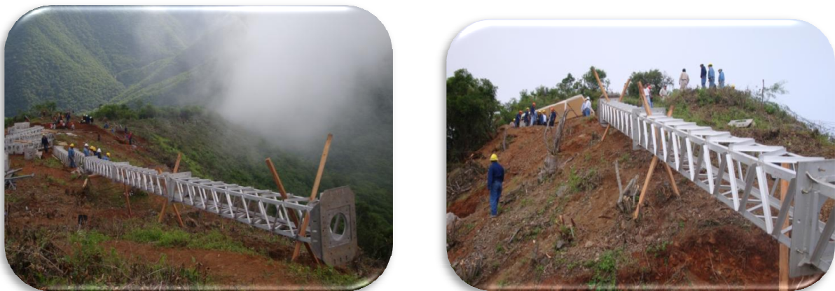
Figura 110. Armado de la primer columna en piso.
