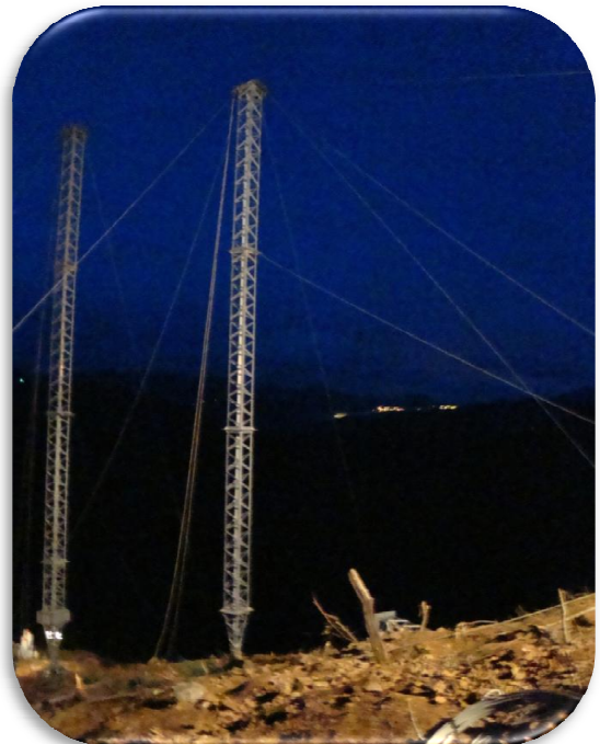
Figura 115. Izaje de la segunda columna de la estructura de emergencia
