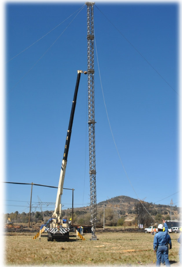
Figura 134 Izaje de la estructura con una grúa Telect
