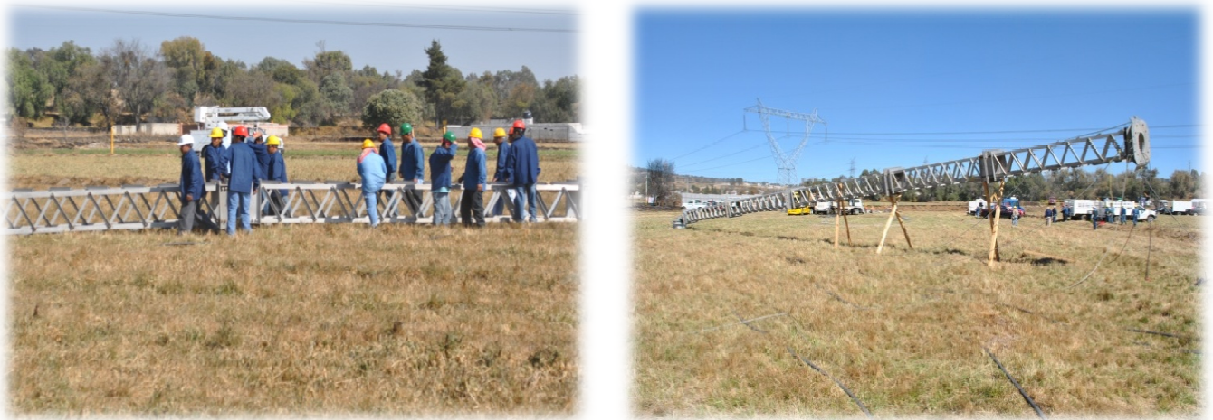
Figura 132. Armado de las columnas en piso.
