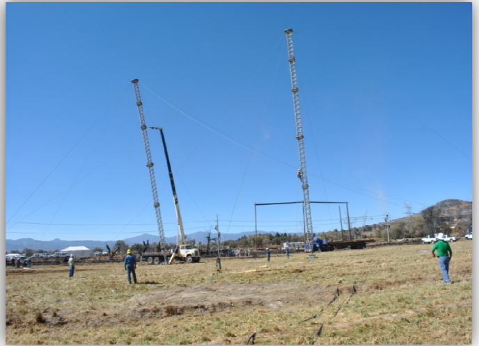
Figura 133. A la izquierda se observan las columnas armadas en piso, en tanto que a la derecha se observa la maniobra realizada con grúa.
