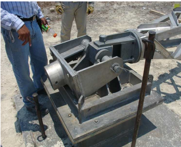
Figura 53. Maniobra para izar columna con pluma en la base
