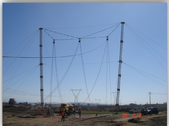
Figura 135. Maniobras para la subida de conductores a la estructura de emergencia
