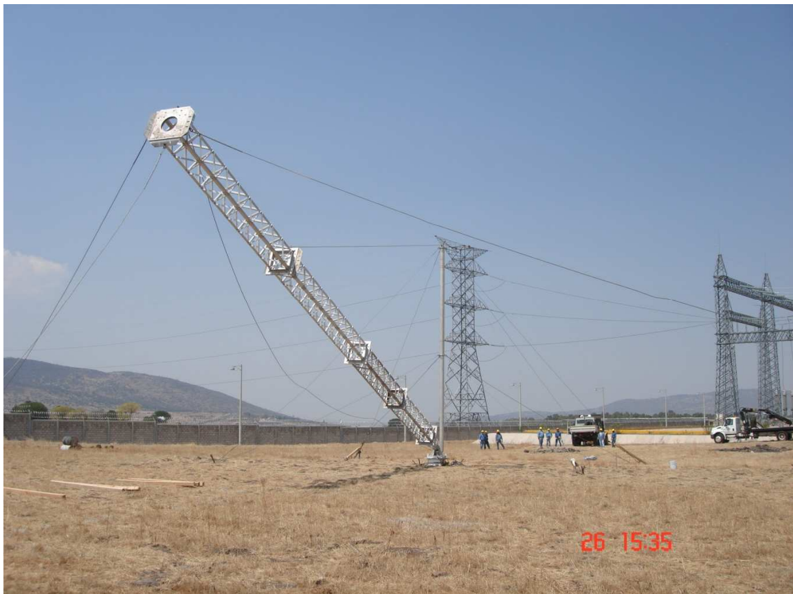
Figura 56. Maniobra para izar la columna con pluma mástil montada en la base fija.
