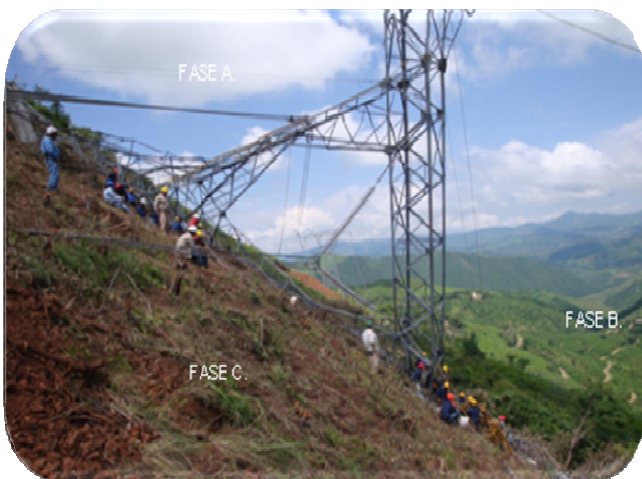
Figura 101. Disposición de conductores en piso de estructura colapsada e identificación de conductores de una de las fases
