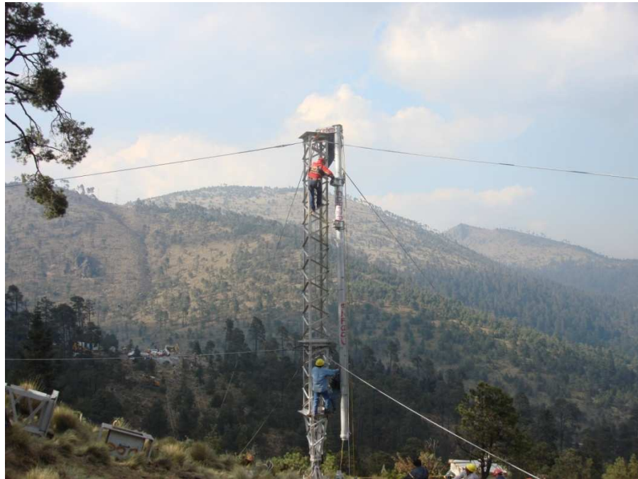
Figura 76. Armado de la T-48 con la pluma deslizante
