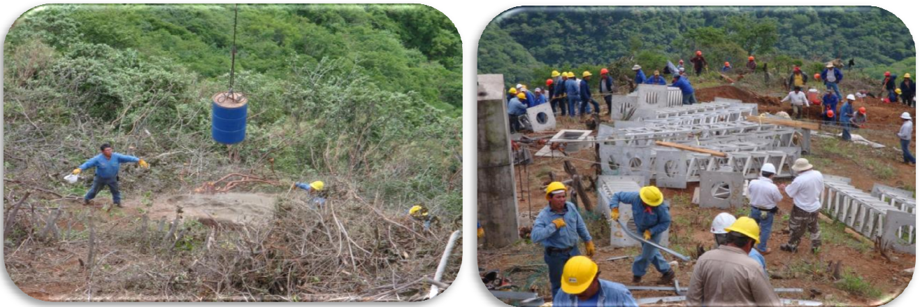
Figura 109. Con apoyo del helicóptero se realizó el traslado de estructura y colocación de muertos
