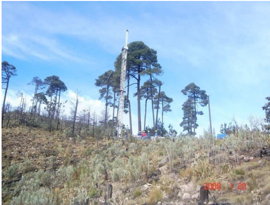
Figura 80. Armado de la T-50 con la pluma deslizante
