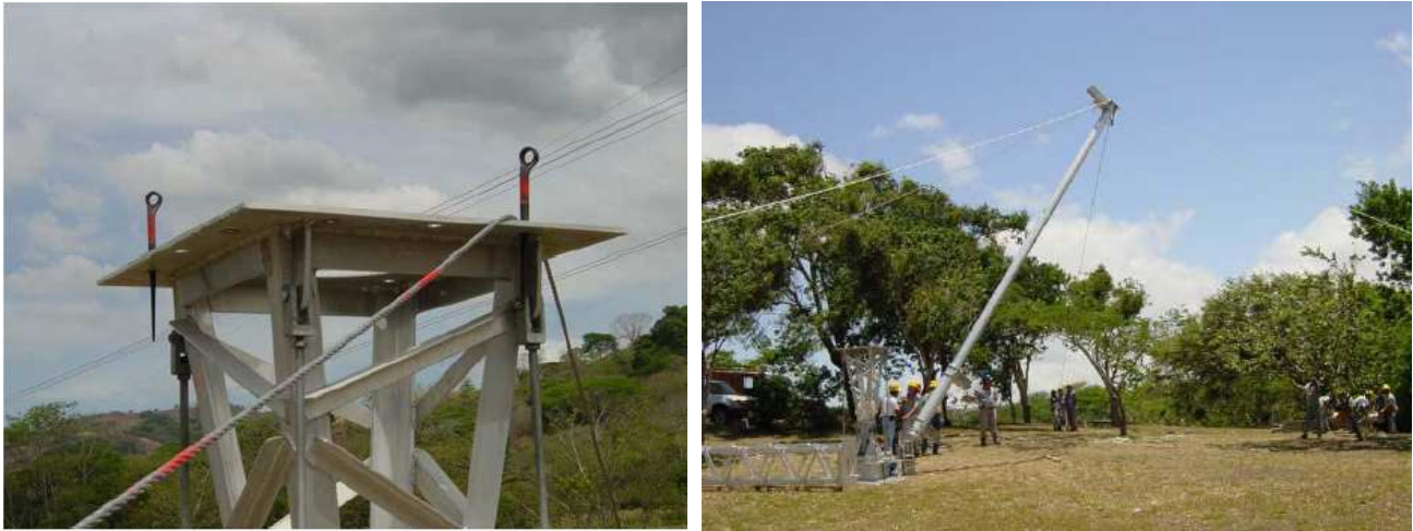
Figura 63. Izaje de la pluma deslizante
