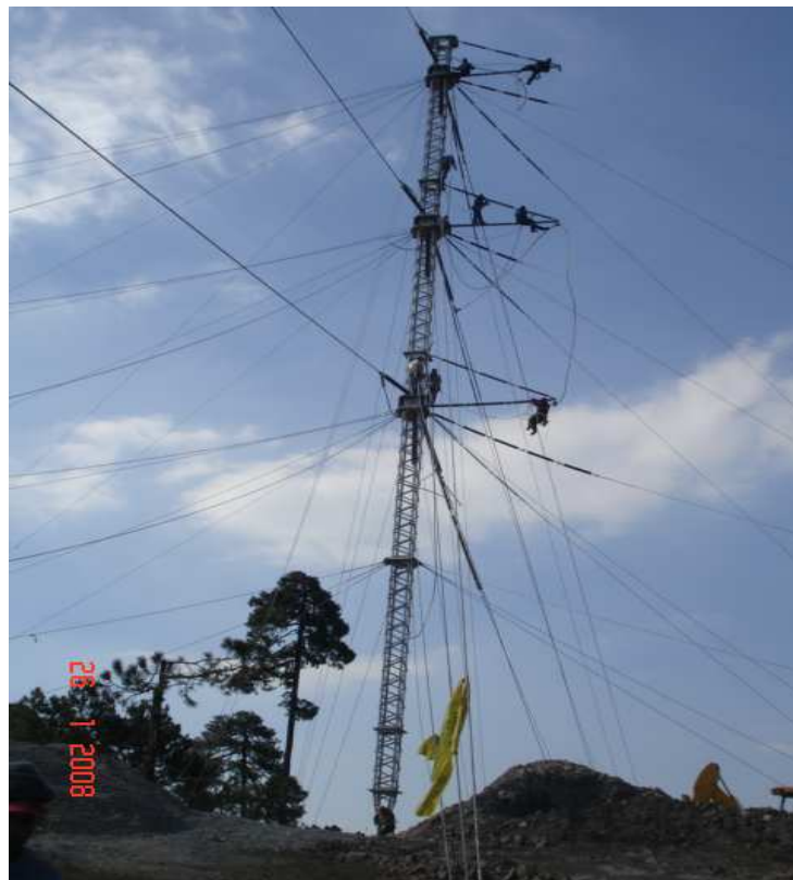
Figura 75. Trabajos realizados en la T-45
