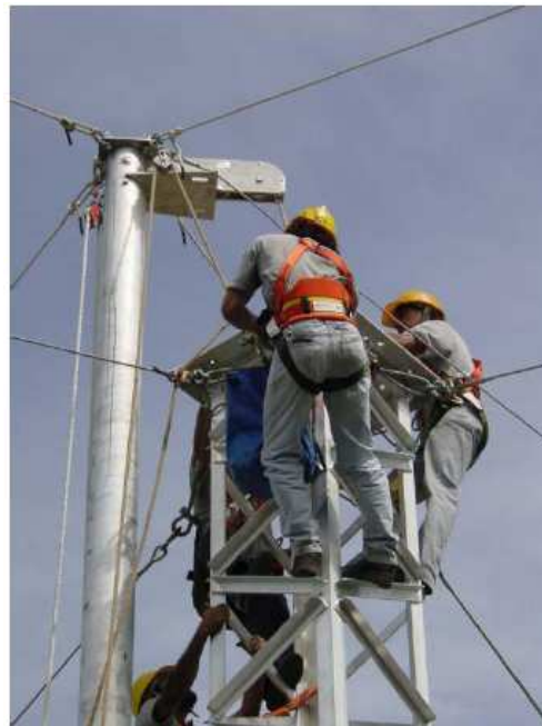
Figura 65. Colocación de retenidas temporales en el primer modulo
