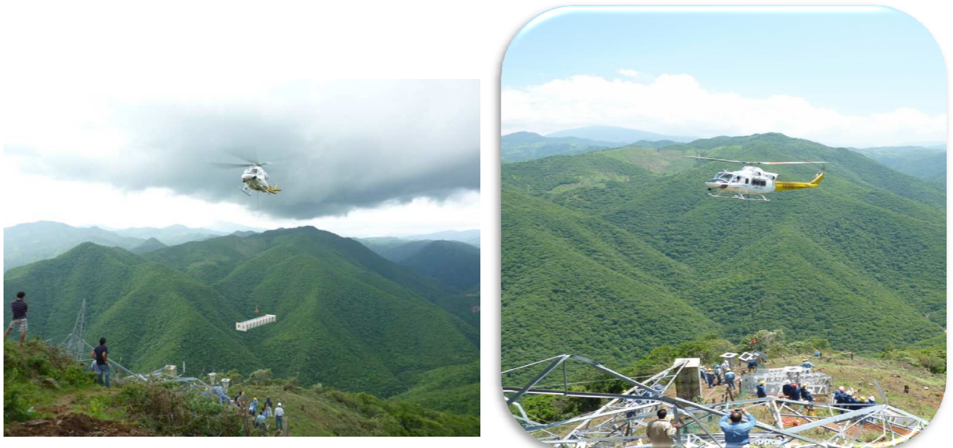
Figura 108. Maniobras de traslado de materiales con helicóptero
