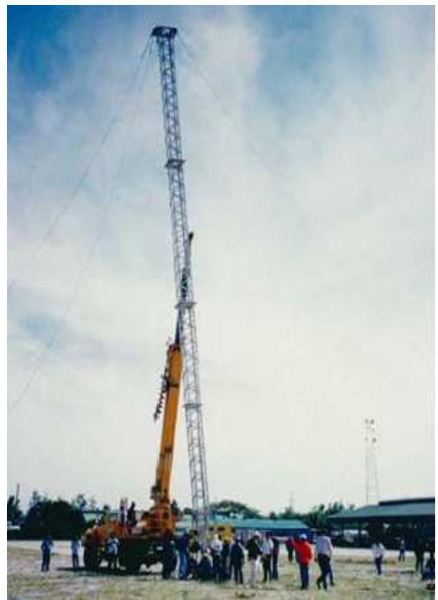
Figura 48. Diagrama y foto del Izaje de columna por el método pivoteada con grúa, centro de gravedad.
