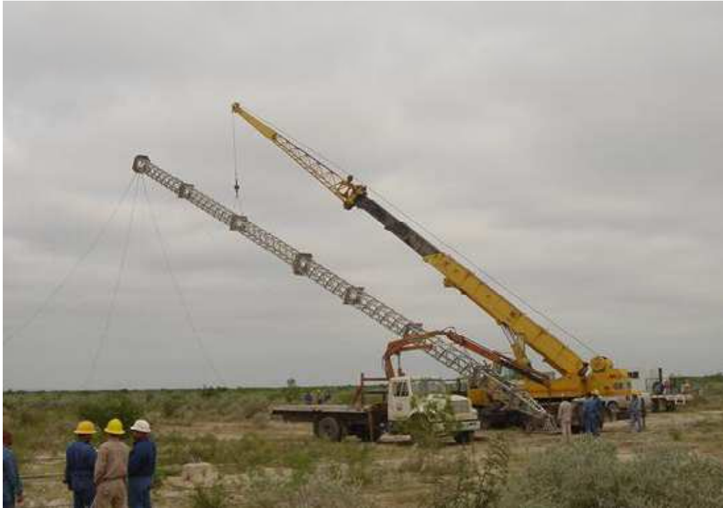
Figura 46. Columna pivoteada sobre su base con grúa.
