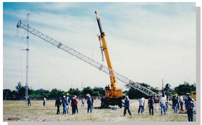
Figura 47. Izaje de columna por el método pivoteada con grúa, centro de gravedad.
