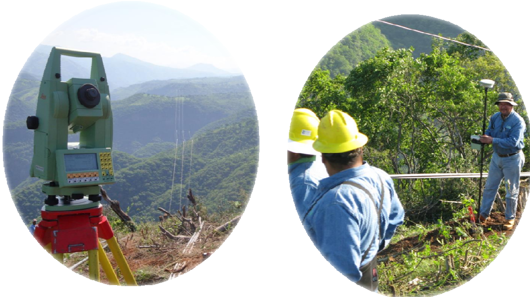
Figura 105. Topografía y trazo de anclas para estructura de emergencia
