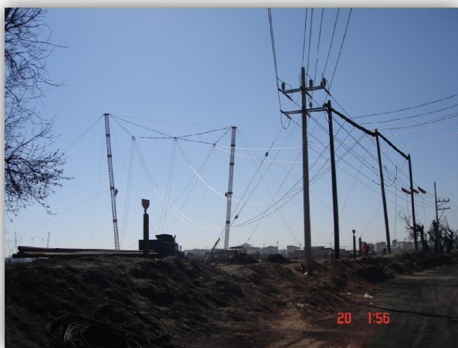
Figura 135. Maniobras para la subida de conductores a la estructura de emergencia
