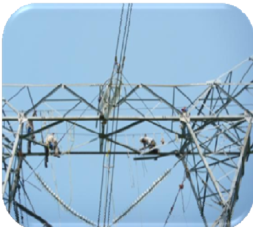
Figura 94. Secuencia de reparación de las traveses de las estructuras No. 494 y 495, se observa que el habilitado de algunos elementos se tuvo que realizar en campo.
