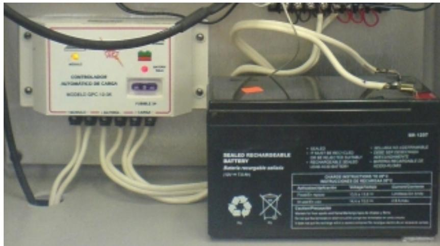
*Figura 3.18. Conexiones entre el controlador de carga y la batería en la estación remota.*
