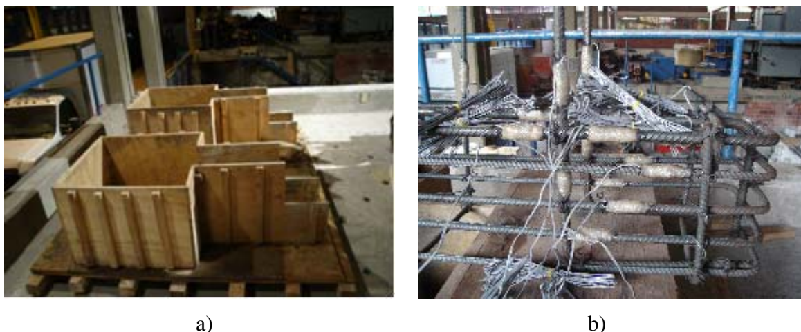
Figura 3.4. Proceso constructivo de los especímenes. a) Cimbra de triplay usada para el colado de los especímenes, montada sobre una plataforma. b) Deformímetros colocados en barras de refuerzo.
