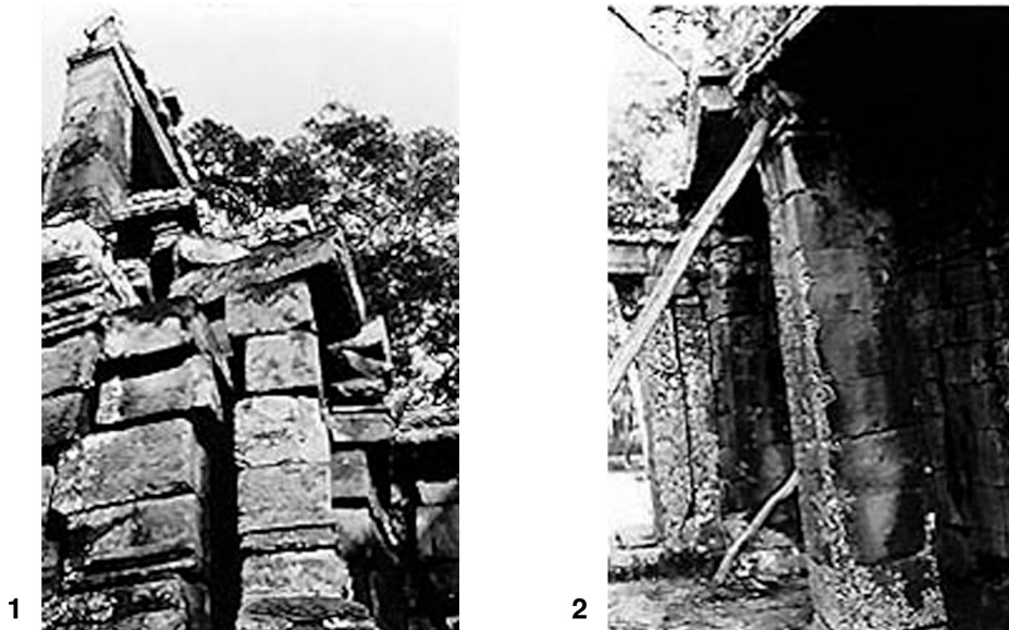
1. vista de la biblioteca norte del Templo Bayon 2. columna apuntalada debido al precario estado de conservación
