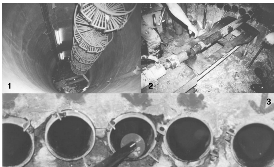
1. lumbrera de acceso a la los suelos blandos 2. tubos sub-excavadores hincados a presión con cilindro hidráulico 3. detalle de las ventanas por las que penetran los tubos
