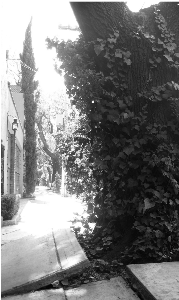
Los efectos de la plantación de árboles cercanos a las construcciones pueden ser muy destructivos.
