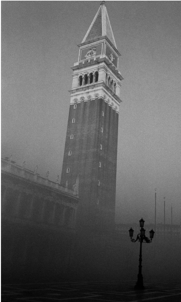
El Campanario, después de derruido, permanece, tal cual como lo construyeron en el siglo XVI.
