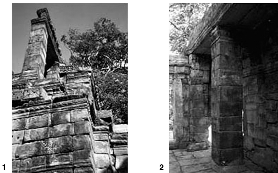
1. vista de la biblioteca norte del Templo Bayon 2. columna totalmente restaurada
