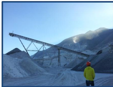
Figura 79. Banda transportadora de un sector secundario.
