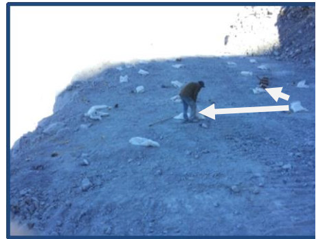
Figura 73. Espaciamento entre filas y barrenos
