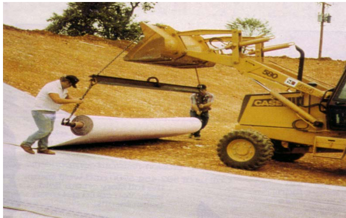
FIG. 1. PREPARACIÓN DE LOS PATIOS DE LIXIVIACIÓN.
