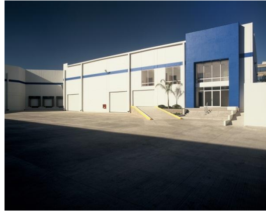
Figura 4.10. Nave de muros prefabricados.
