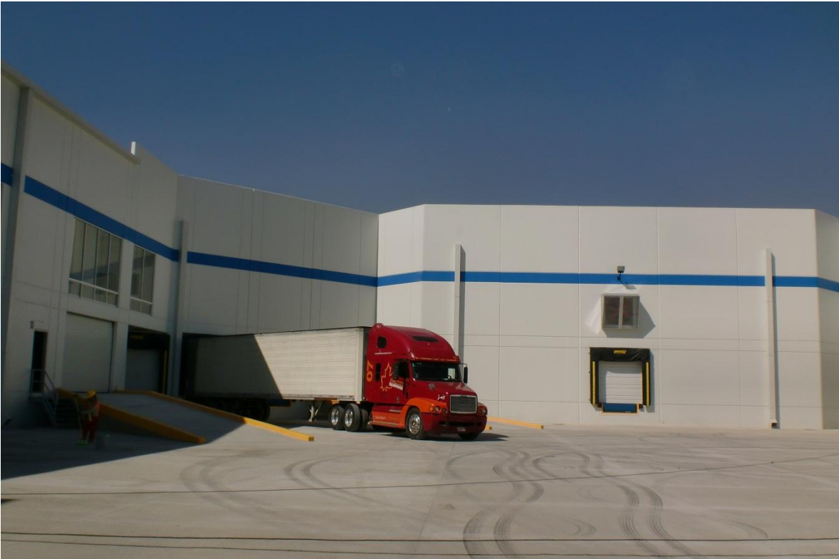
Figura 3.3. Vista del patio de maniobras.
