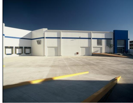
Figura 4.4. Nave industrial terminada.
