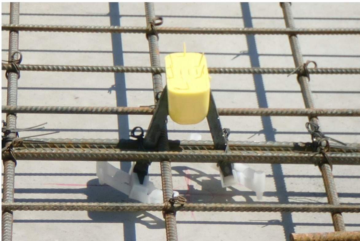
Figura 5.15. Colocación de lifting insert.
