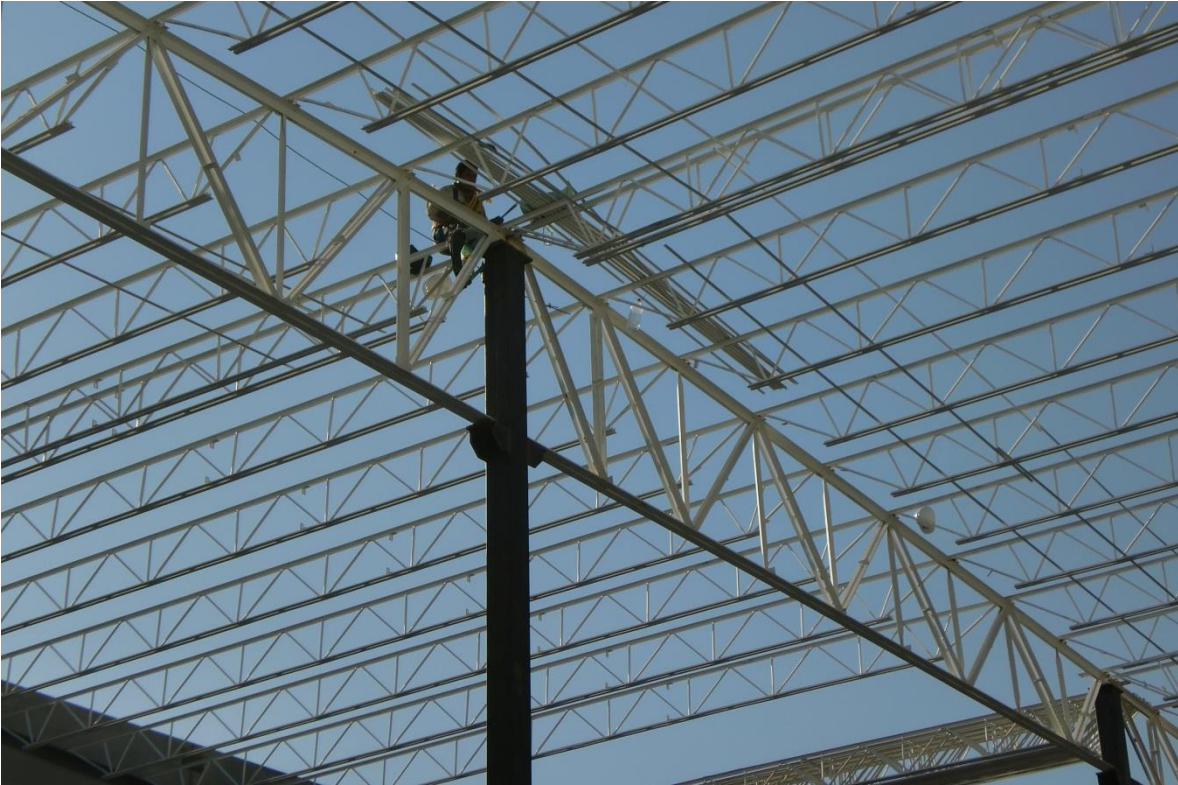
Figura 3.14. Montaje de armadura principal.
