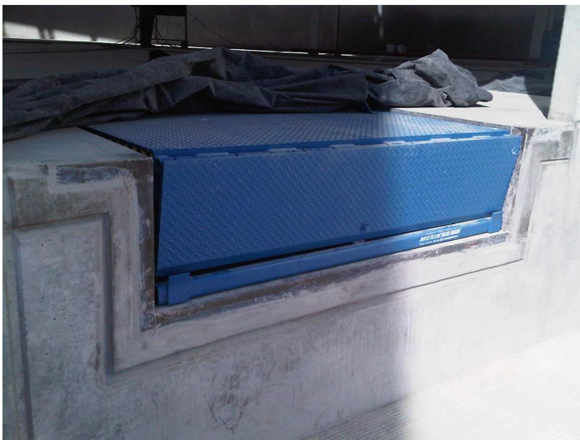
Figura 3.21. Instalación de docks levelers.
