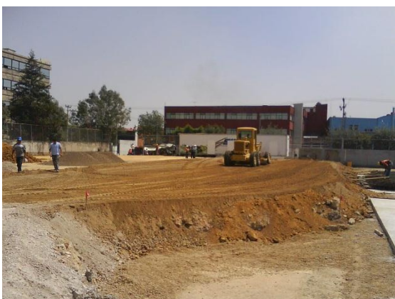
Figura 5.1. Formación de la plataforma.
