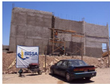
Figura 4.1. Construcción de nave industrial con muros prefabricados de concreto.
