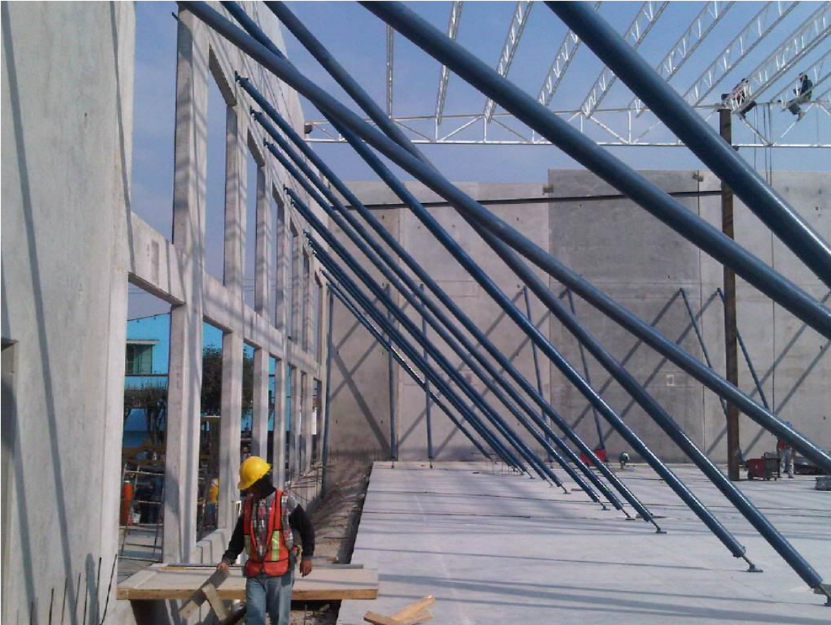
Figura 5.25. Conjunto de muros izados y colocados.
