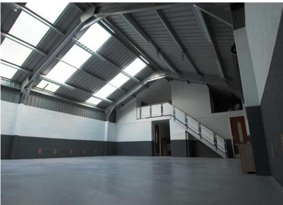
Figura 4.11. Interior de nave con columnas perimetrales.
