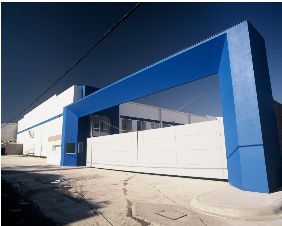
Figura 3.4. Marco de acceso principal.
