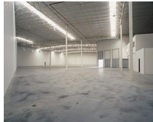
Figura 4.12. Interior de nave sin columnas perimetrales.
