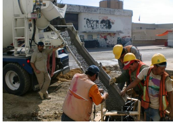
Figura 4.14. Concreto de planta.
