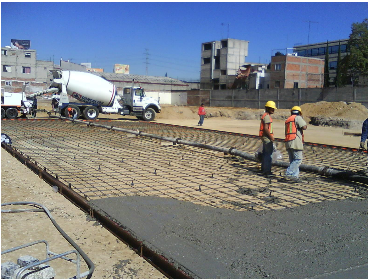
Figura 5.9. Colado de la losa de patio de maniobras.
