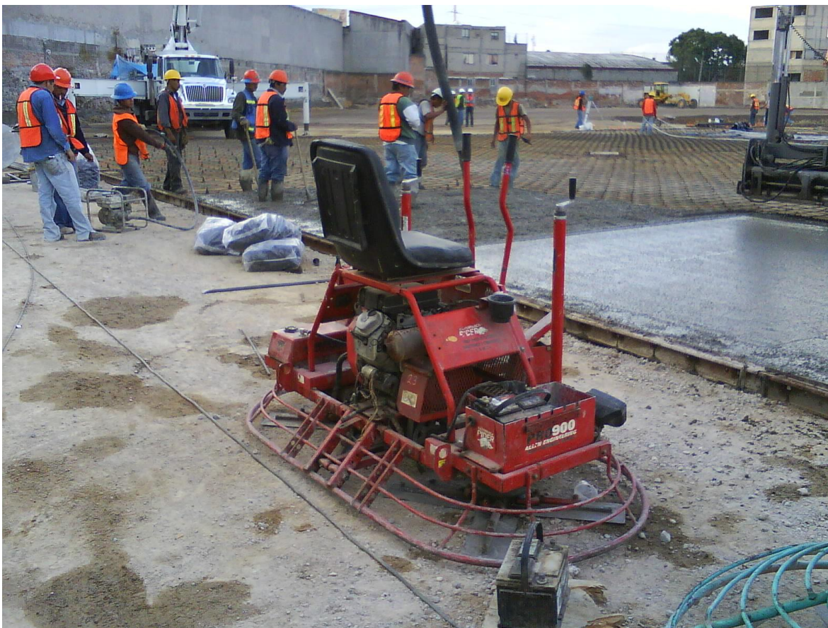
Figura 5.8. Llana mecánica doble.
