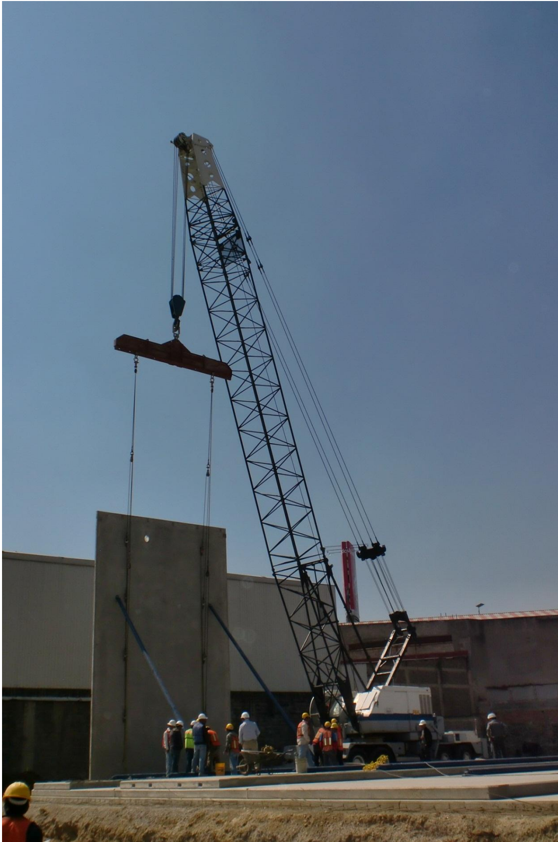
Figura 5.24. Elevación de un muro.
