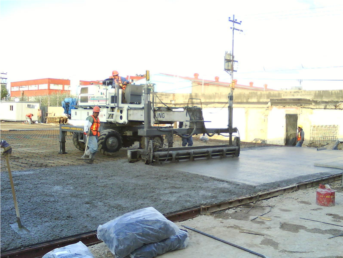
Figura 5.7. Máquina laser en operación.
