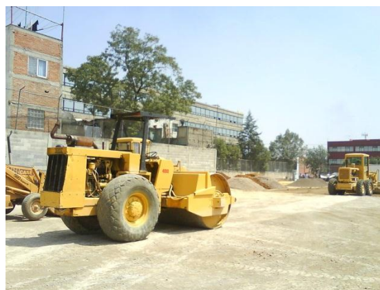
Figura 5.2. Compactación de la plataforma.
