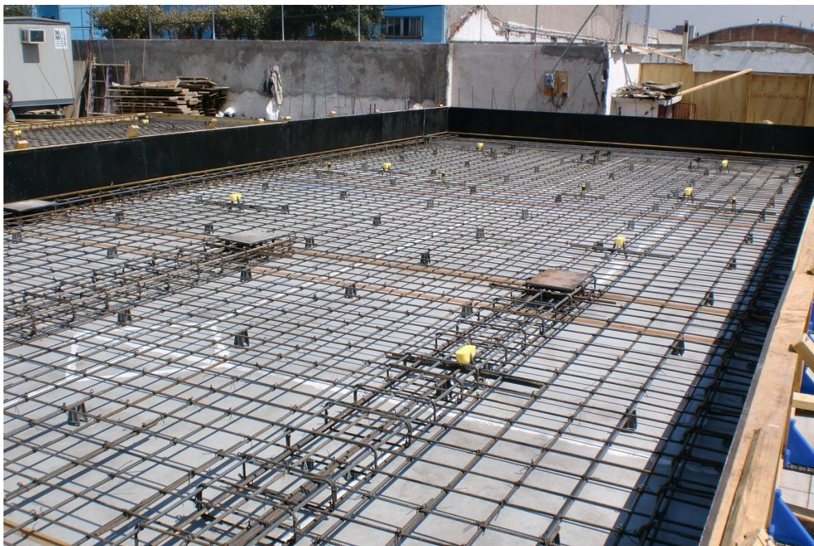
Figura 5.17. Armado final de un panel.
