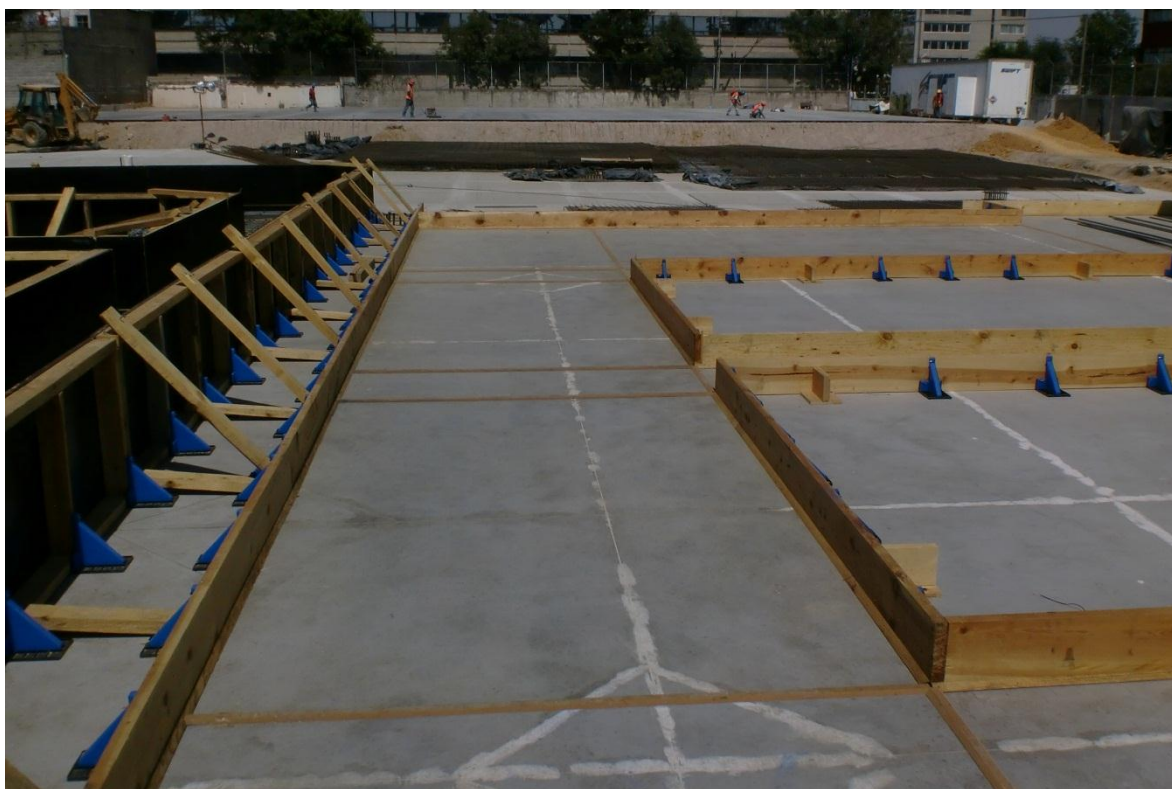
Figura 5.10. Cimbra para muros de concreto.
