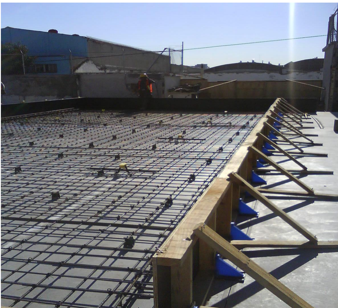
Figura 5.13. Armado de paneles con acero y silletas.
