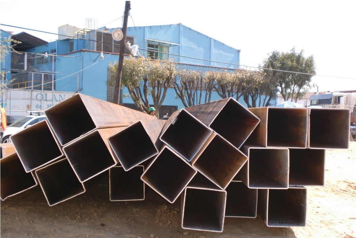
Figura 3.12. Columnas HSS en obra.
