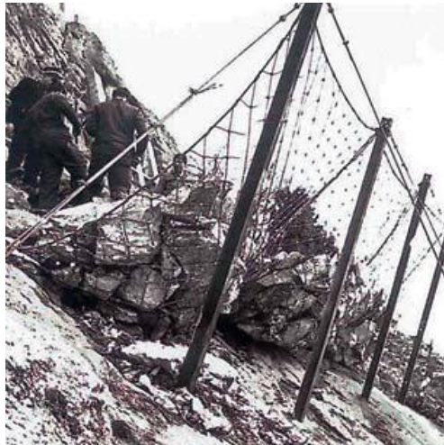
Figura 1.13 Sujeción de redes en la barreras.
