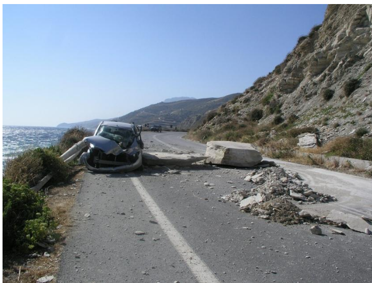
Figura 2.5 Ejemplos de falla de taludes en roca.
