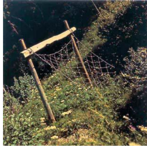
Figura 1.3 Primeras barreras individuales con marco a base de madera.
