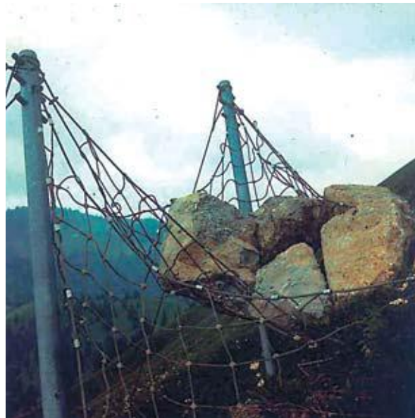
Figura 1.4 Barrera colocada para la protección contra hielo.
