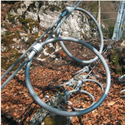
Figura 3.24 Anillo de frenado con casquillo prensado.
