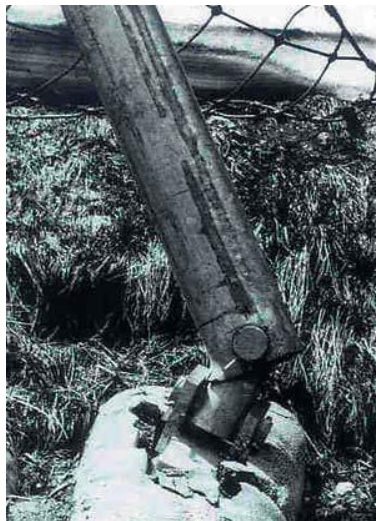
Figura 1.15 Apoyo articulado en la base de los postes.
