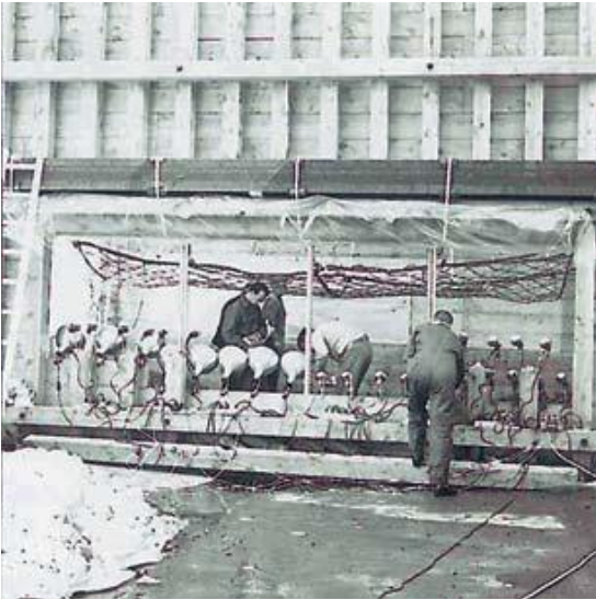
Figura 1.5 Primeras pruebas en barreras con redes de cable de acero.
