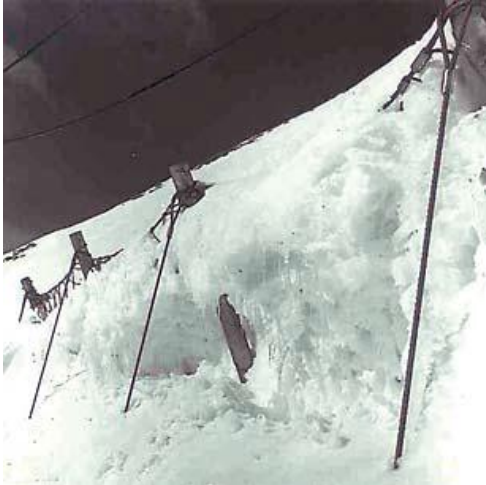
Figura 1.2 Barrera a base de red de cable para control de avalanchas.
