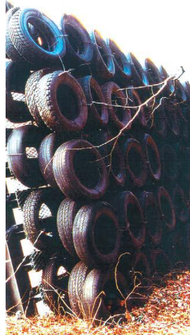
Figura 1.6 Propuesta de las primeras pantallas para el control de caídas de rocas.
