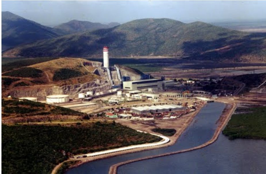
Fig 4.8 Central Termoeléctrica Juan de Dios Batíz Paredes, Zapeda
