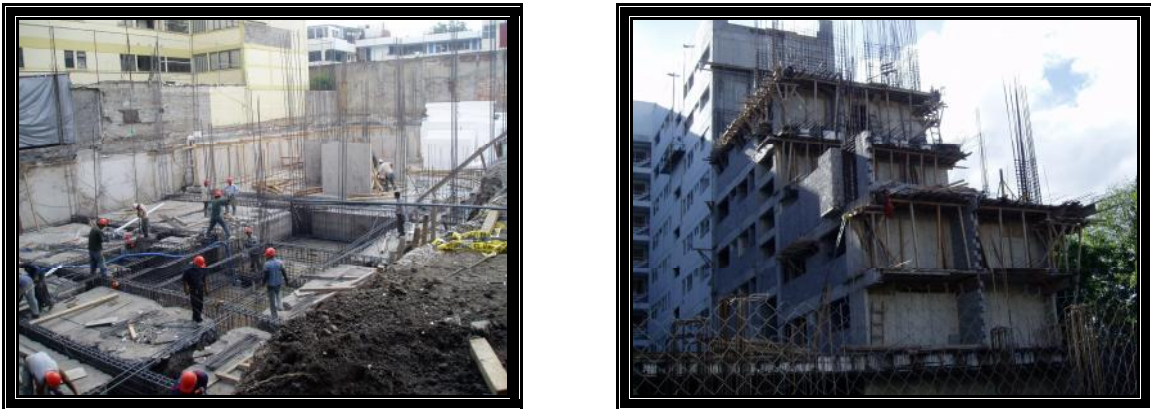
Figura 5.5. Ruido y partículas suspendidas en obras de construcción Fuente: Elaborada por la autora
