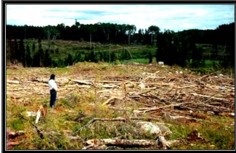
Figura 2.13. Limpieza del terreno Fuente: http://images.google.de
