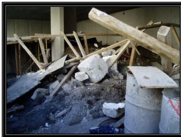
Figura 5.7. Residuos en obras de remodelación Fuente: Elaborada por la autora
