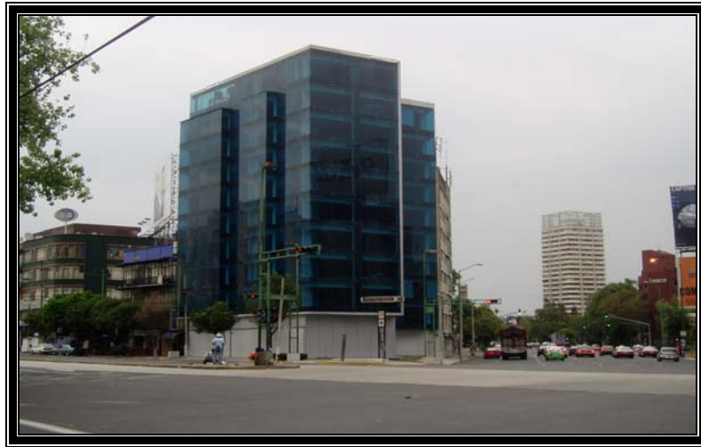
Figura 2.9. Vidrio colocado en la ventanería de un edificio Fuente: Elaborada por la autora
