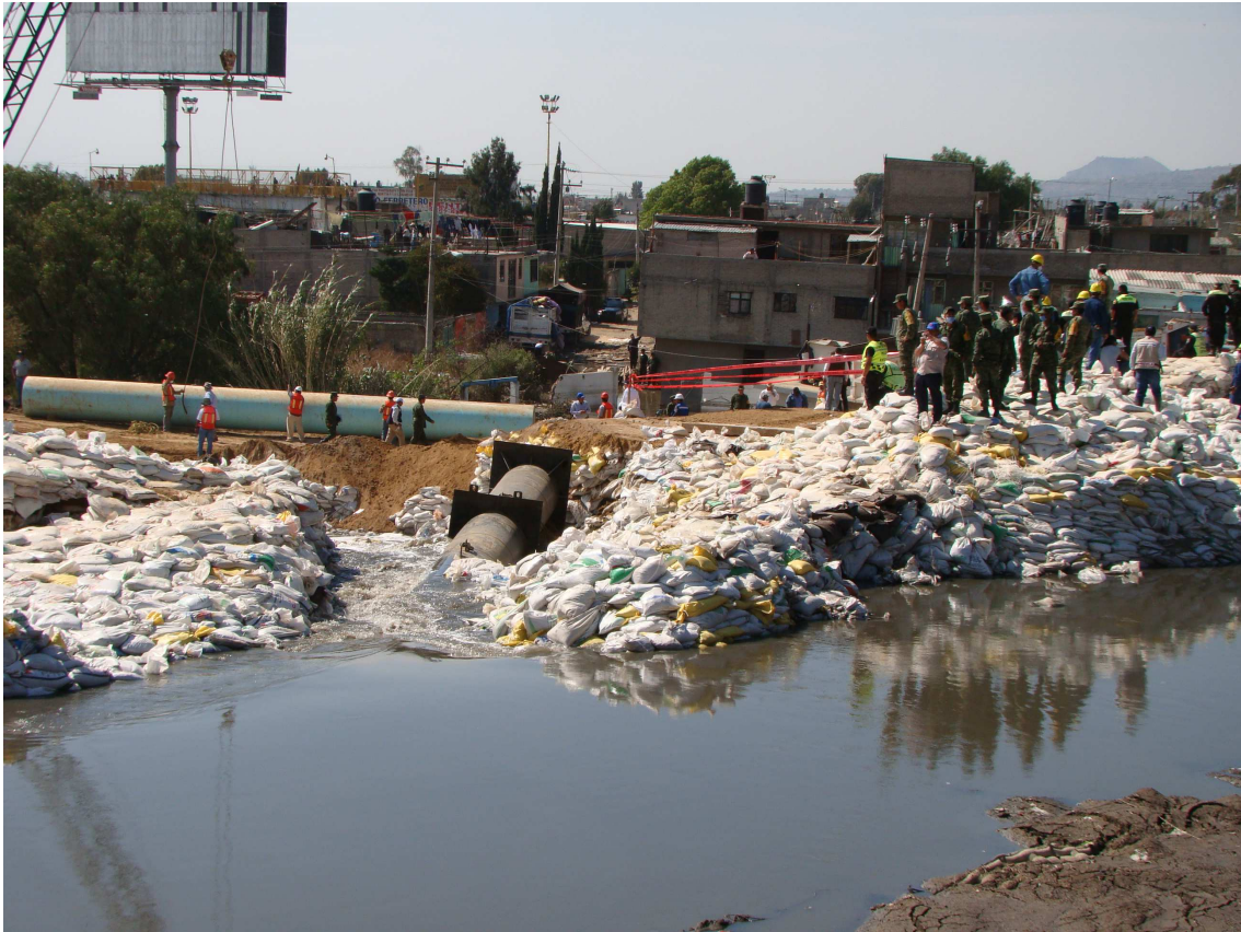
Figura 4.3. Trabajos para dirigir el agua hacia el río de la compañía
