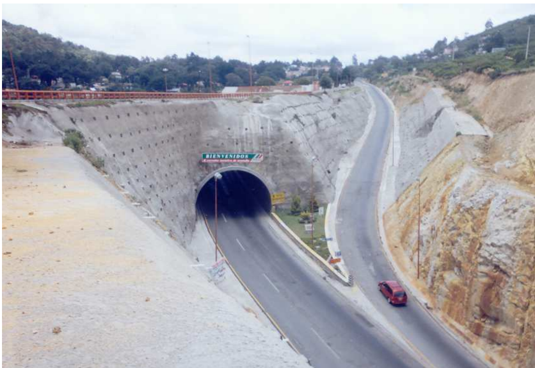
Imagen 31. Entrada al túnel mediante el portal poniente. En donde se realizaron los trabajos de anclaje Y drenaje correspondiente a los taludes sobrevacante y adyacente al mismo portal, así como el revestimiento respectivo.
