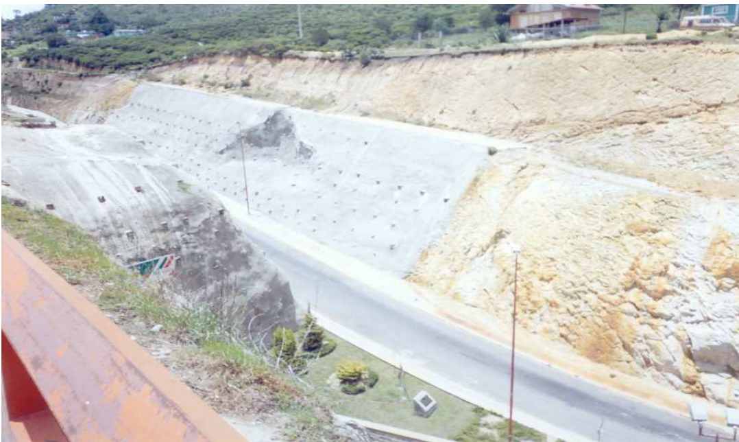
Imagen 34. Vista de la desviación hacia Real del Monte, en donde se observa también el revestimiento con concreto lanzado que se realizó con el mismo fin que se persigue al buscar dar una seguridad al tránsito en cualquier autopista.
