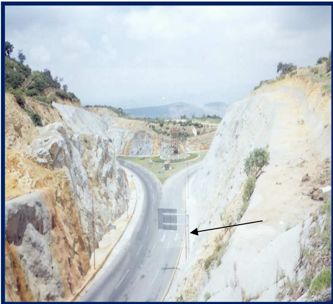
Imagen 24. Entrada al túnel en el cual se brinda el espacio adecuado para el tránsito de vehículos, y que por ningún motivo se reduce el espacio para acceder a él. Obsérvese el espacio brindado al señalamiento informativo
