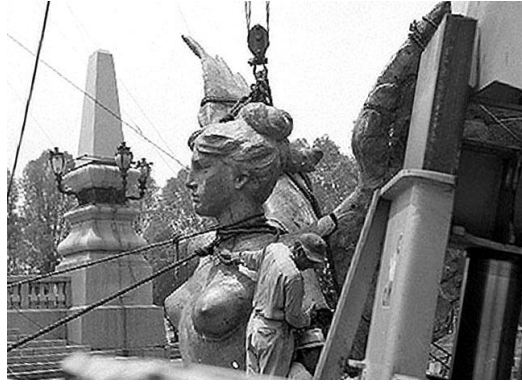
Figura XII Maniobras de colocación de la escultura del Ángel a su posición en la columna
