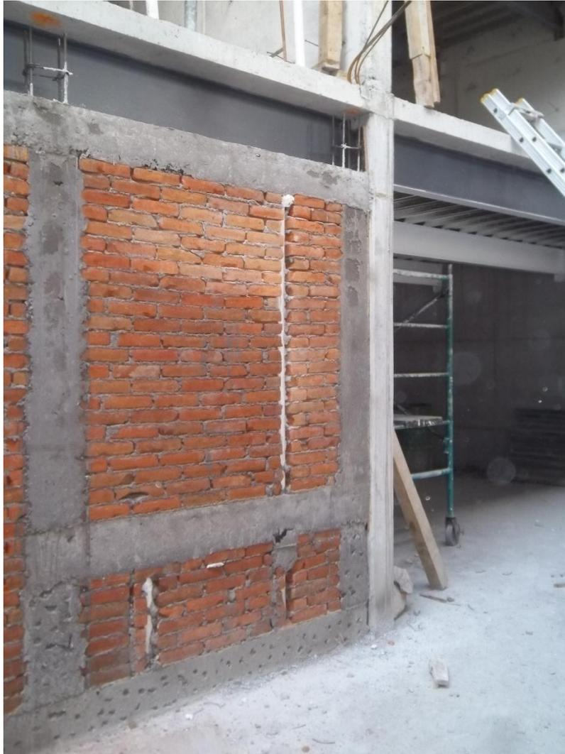
Figura 3.3.6 Muros de tabique
