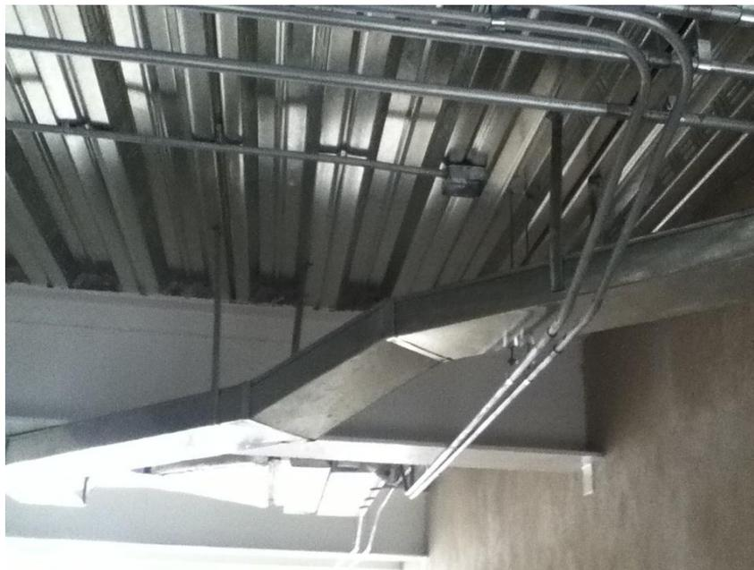
Figura 3.4.1 ductos eléctricos y de aire acondicionado
