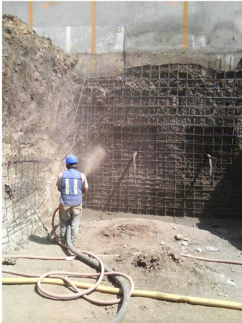
Figura 3.2.2 Concreto lanzado
