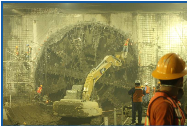
Fotografía de la llegada de la tuneladora EPB a la estación Mexicaltzingo
