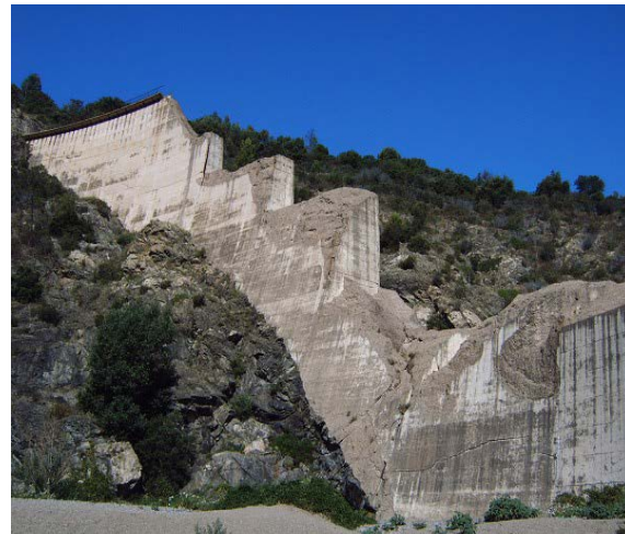
Fig. 4.10 a) Deslizamiento de laderas en la Presa Vajont, Italia (imágenes tomadas de la Ref.12 Internet); b) Presa Malpasset de arco-bóveda de doble curvatura antes y después del colapso debido al debilitamiento de la cimentación (imágenes tomadas de la Ref.6 Internet).
