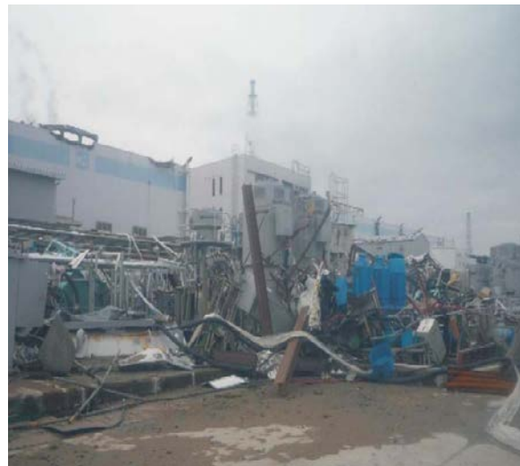
Fig. 4.4 Algunos daños generados por el terremoto y el tsunami en la central nuclear de Fukushima (imágenes tomadas de la Ref.14).
