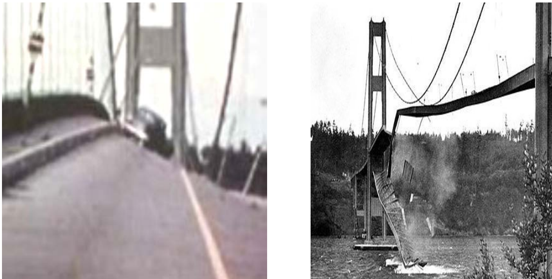
Fig. 4.18 Resonancia y colapso del Puente Tacoma Narrows, Estados Unidos (imágenes tomadas de la Ref.10 Internet).
