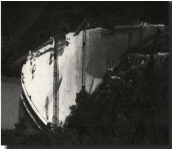
Fig. 4.10 a) Deslizamiento de laderas en la Presa Vajont, Italia (imágenes tomadas de la Ref.12 Internet); b) Presa Malpasset de arco-bóveda de doble curvatura antes y después del colapso debido al debilitamiento de la cimentación (imágenes tomadas de la Ref.6 Internet).
