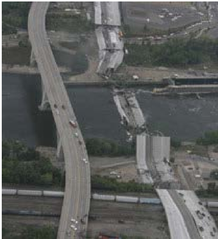
Fig. 4.20 Colapso del Puente Minneapolis, Estados Unidos (imagen tomada de la Ref.9 Internet).
