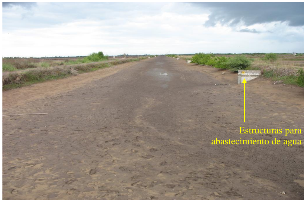
Figura 49. Vista longitudinal del canal de alimentación.
