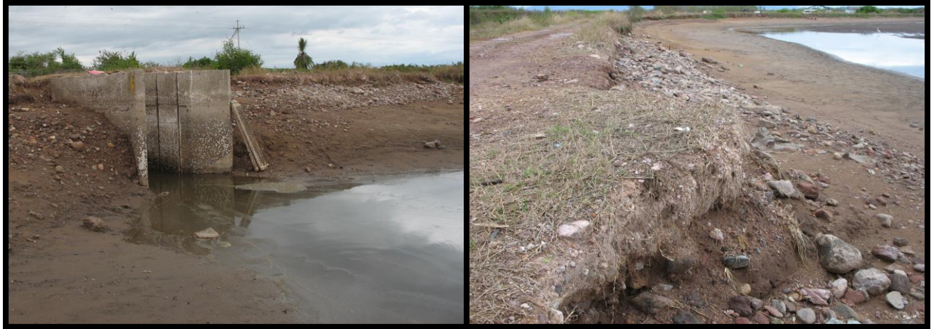
Figura 53. Bordos erosionados.
