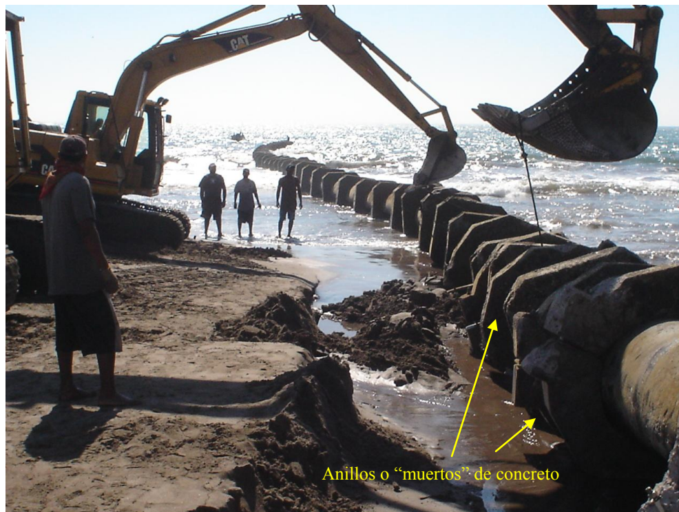
Figura 11. Instalación de la tubería de succión.
