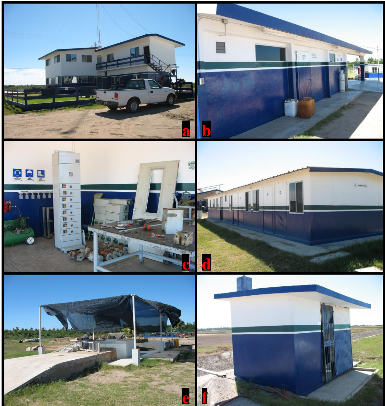
Figura 35. Edificaciones de la granja: a) casa-habitación y oficina, b) bodega alimentos, c) taller, d) dormitorios, e) estación post-cosecha, f) caseta para el centro de control de máquinas.
