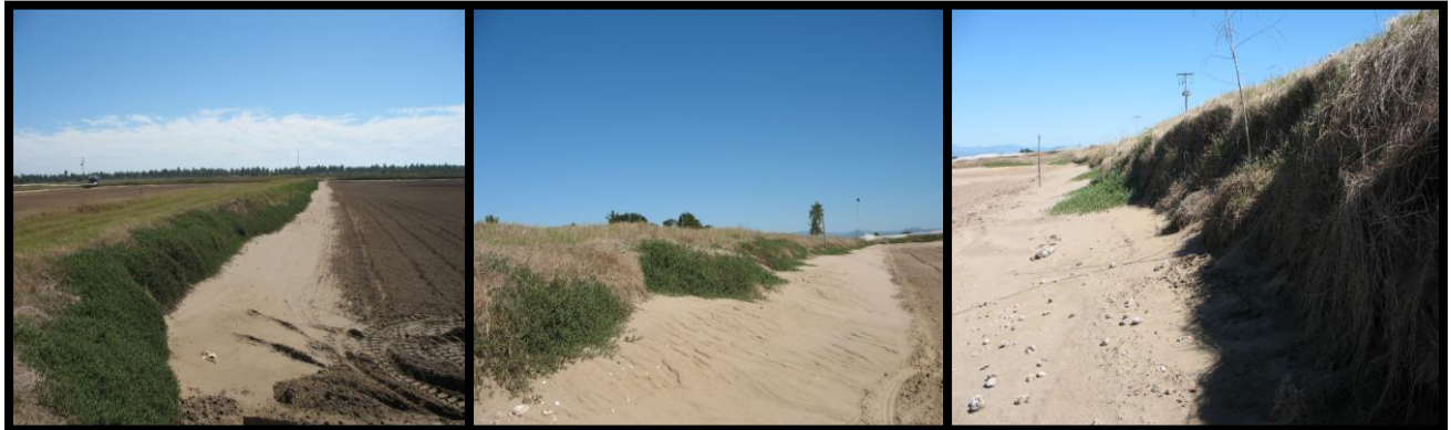
Figura 29. Bordos erosionados.
