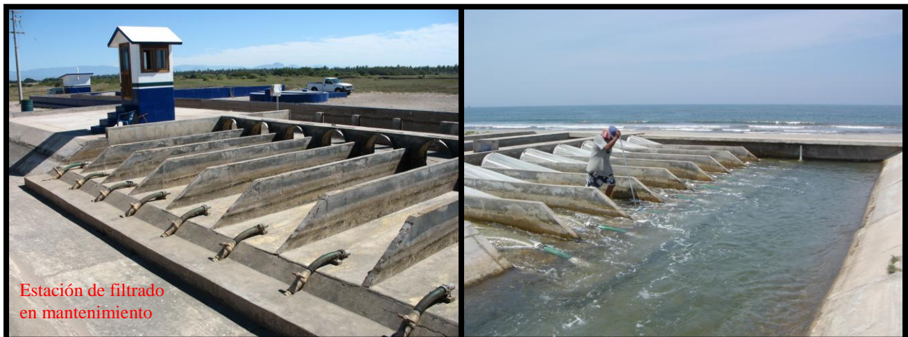
Figura 19. Vistas de la estación de filtrado.
