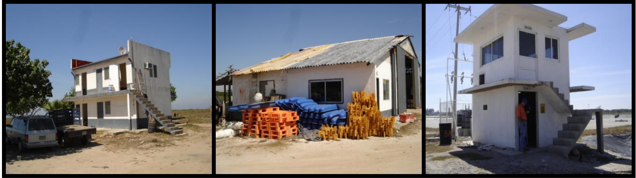
Figura 85. Algunas edificaciones de la granja.
