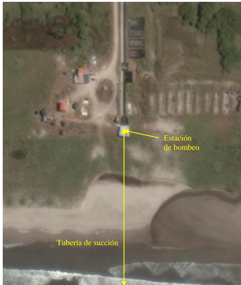
Figura 69. Ubicación de la tubería de succión.
