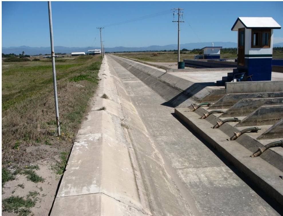
Figura 20. Vista del tramo principal del canal de alimentación.
