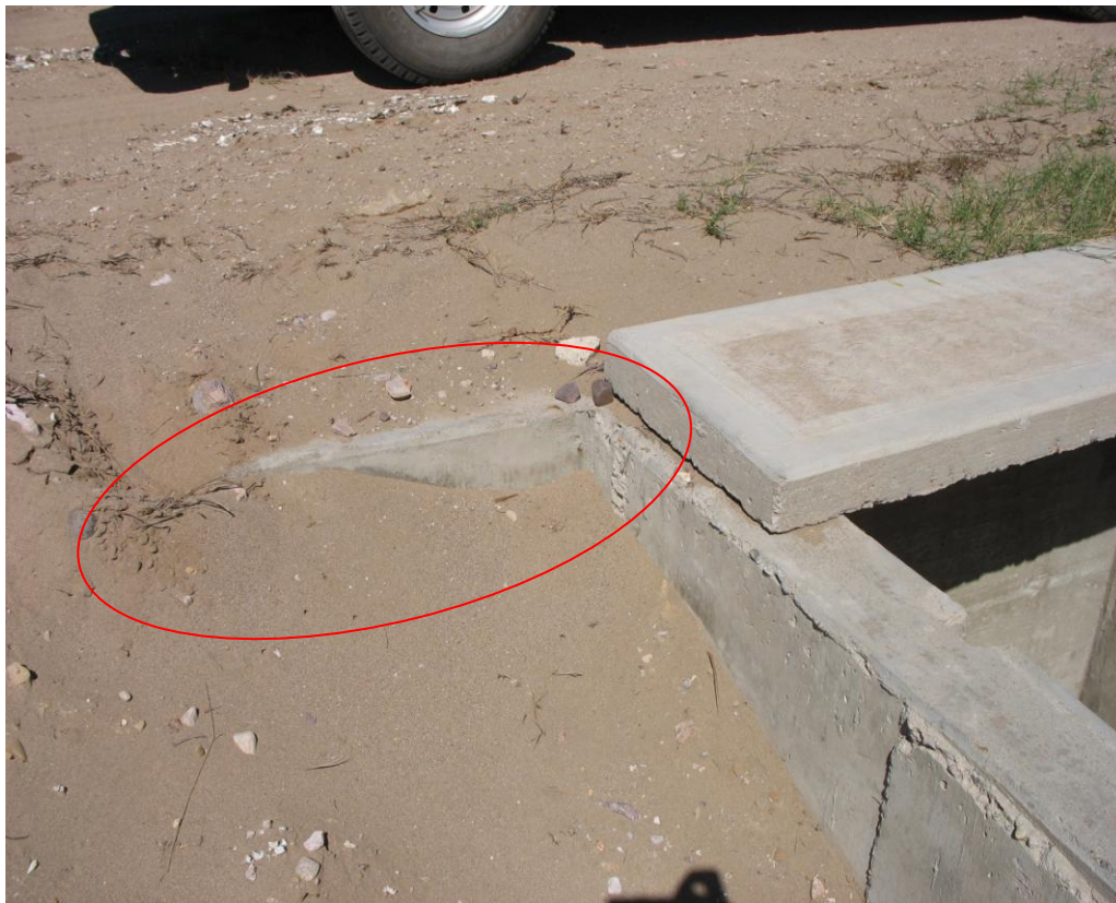
Figura 28. Detalle de trabe colocada para fijar la estructura de salida con el bordo.
