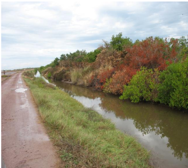
Figura 46. Canal de descarga.
