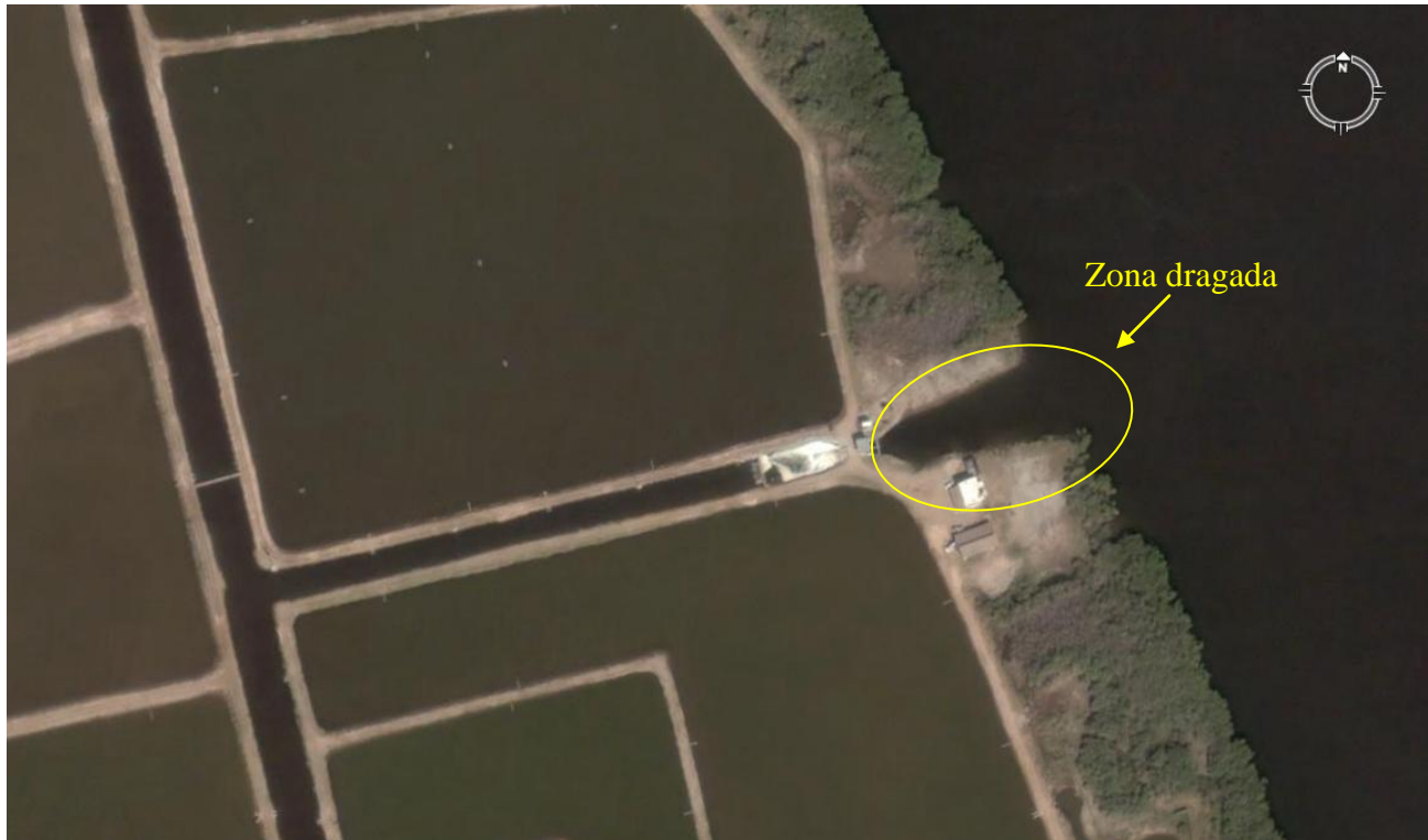
Figura 43. Zona dragada para la toma de agua.
