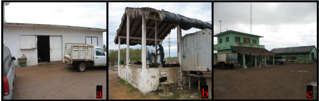
Figura 58. Edificaciones de la granja: a) y b) área norte, c) área sur.
