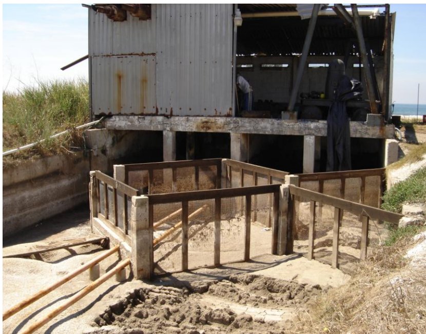
Figura 74. Área del primer paso de filtrado.
