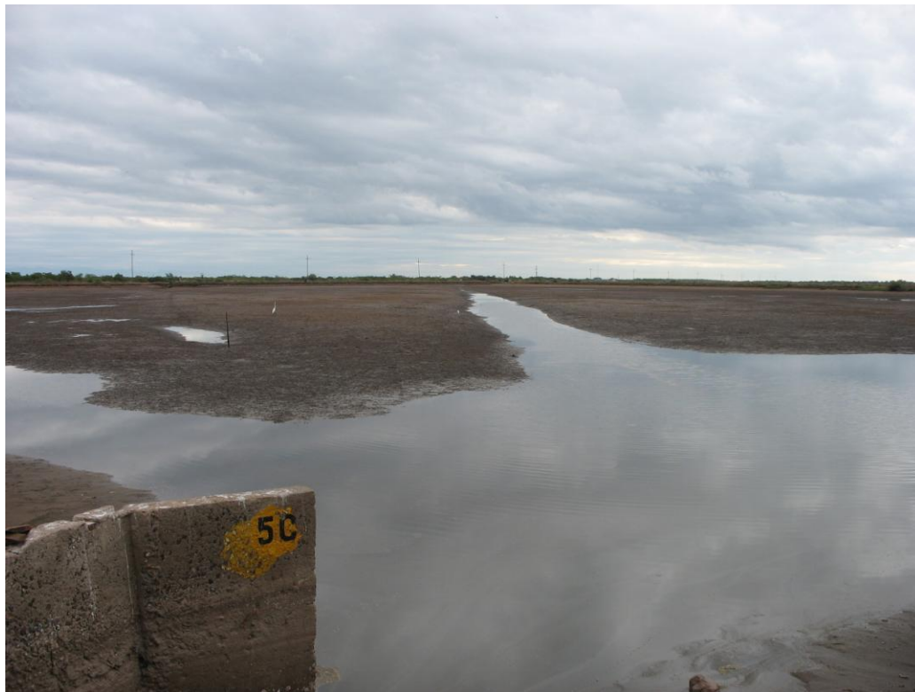
Figura 54. Lagunas producto de la falta de nivelación adecuada en la superficie.
