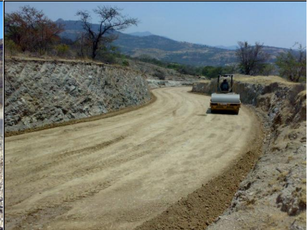
Imagen 6.4 Compactación de Subrasante empleando rodillo liso de placa vibratoria
