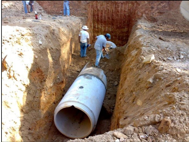
Imágenes 4.5 Construcción de obra de drenaje.
