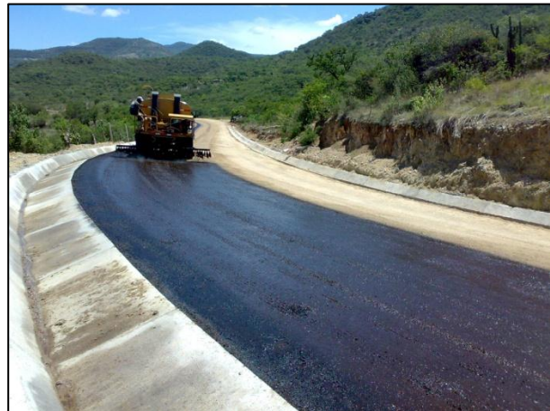
Imagen 6.9 Aplicación de emulsión para riego de impregnación.
