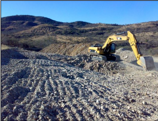
Imagen 6.3 Banco de material para formación de Subrasante.
