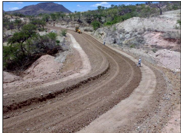
Imágenes 6.2 Tendido de material para formación de capa subrasante.
