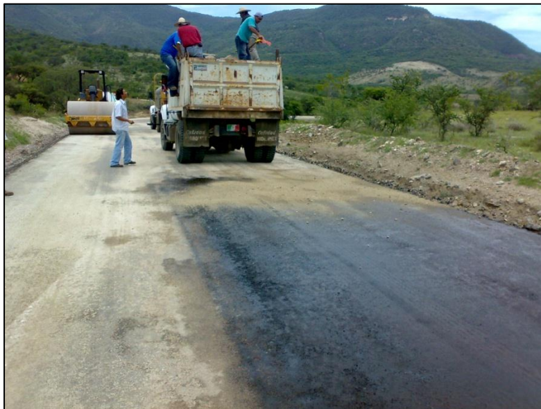
Imagen 6.11 Aplicación de arena para poreo.
