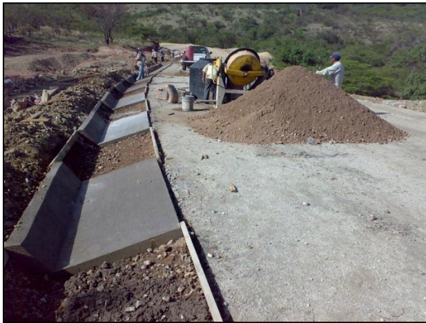
Imágenes 4.6 Construcción de cunetas
