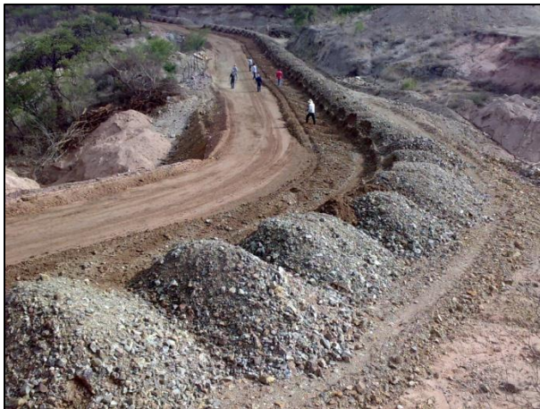
Imágenes 6.2 Tendido de material para formación de capa subrasante.
