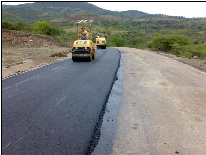
Imagen 6.14 Compactación de carpeta asfáltica
