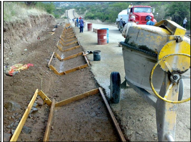
Imágenes 4.6 Construcción de cunetas
