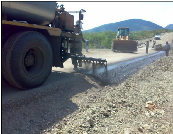
Imagen 6.9 Aplicación de emulsión para riego de impregnación.
