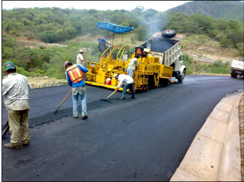
Imagen 6.13 Tendido de mezcla
