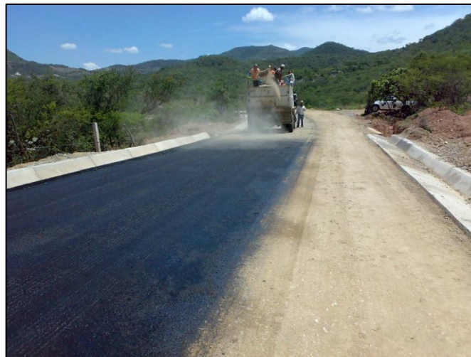
Imagen 6.10 Aplicación de arena para poreo.
