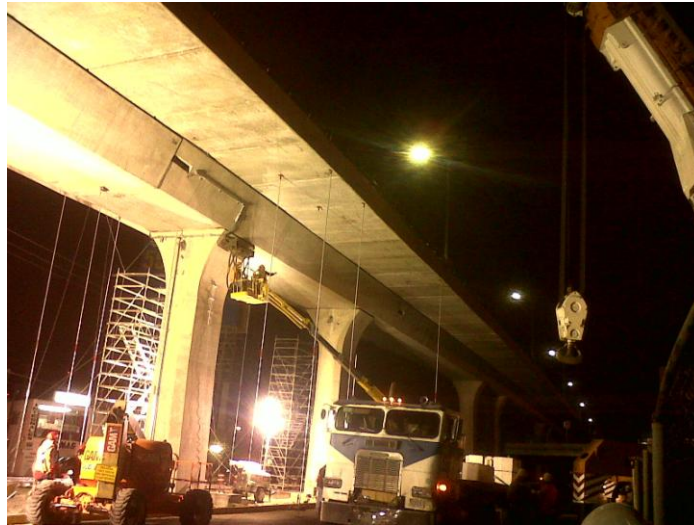
Fig. 3.15 Grúa y polea para prueba de tracción
