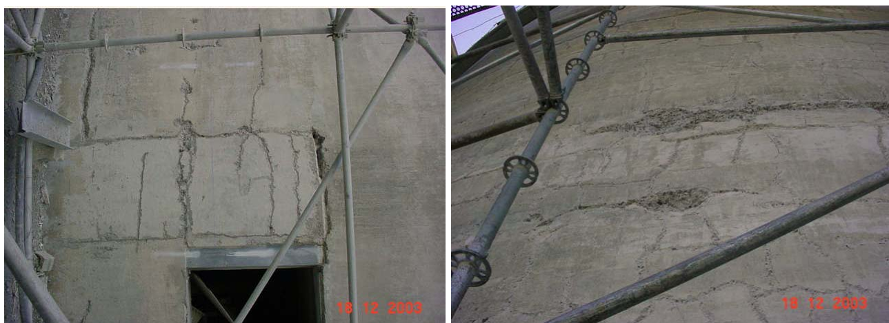
Figura 6.2 Preparación, escarificación y apertura de fisuras y oquedades
