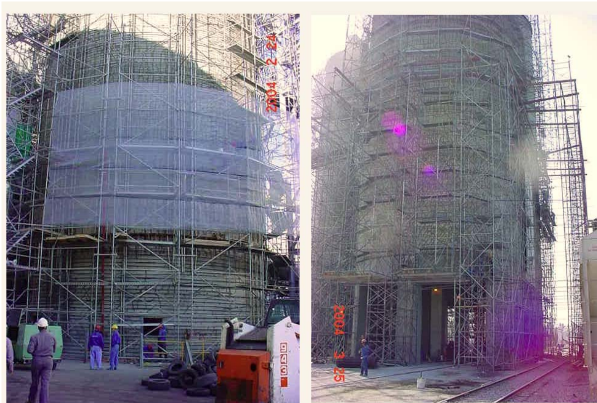
Figura 6.1 Andamio de alta resistencia perimetral con plataformas de trabajo
