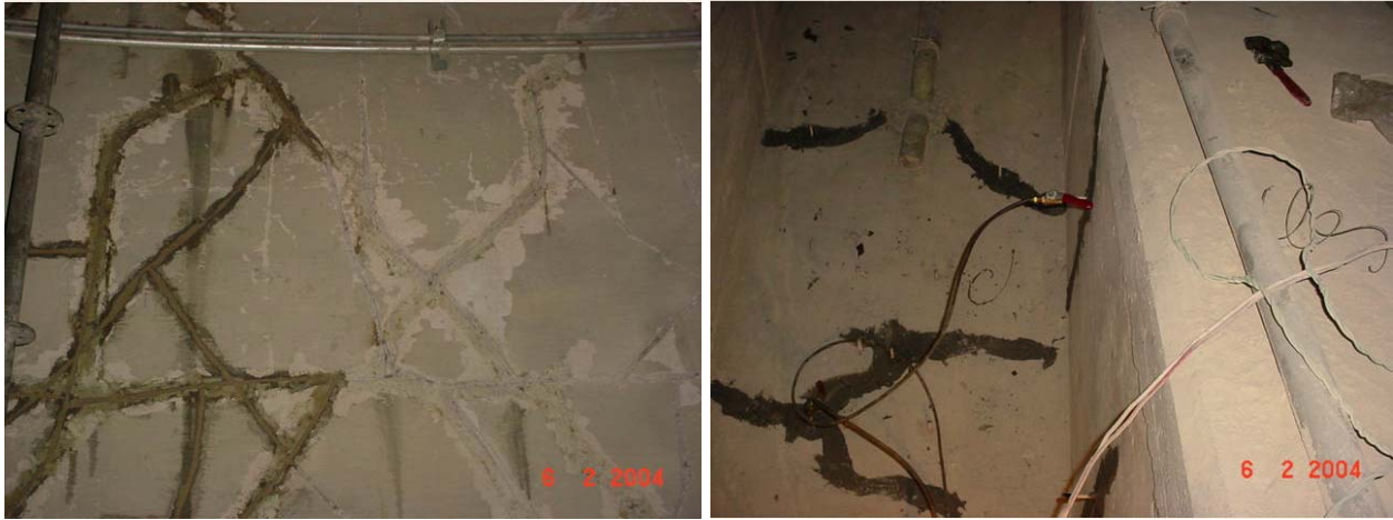
Figura 6.3 Resanado e inyección de fisuras
