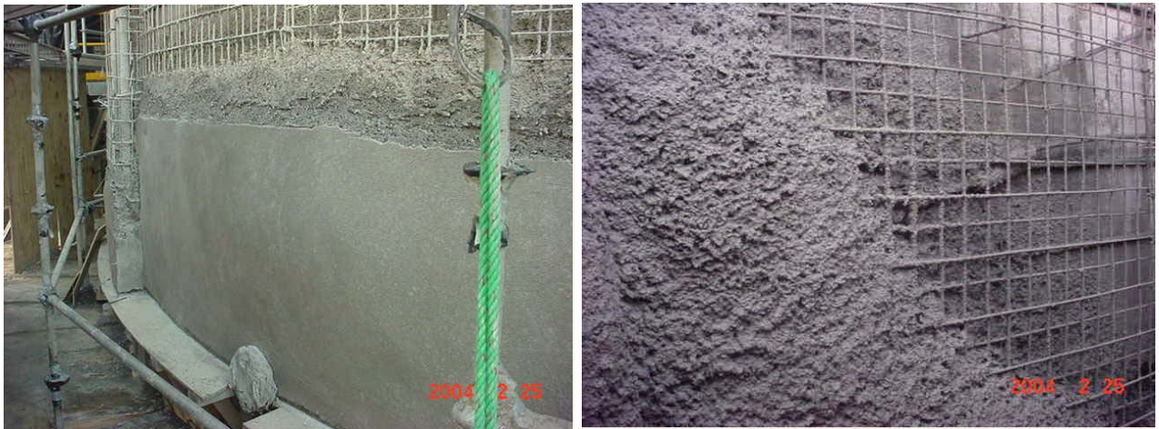
Figura 6.5 Acabado y concreto lanzado en muros
