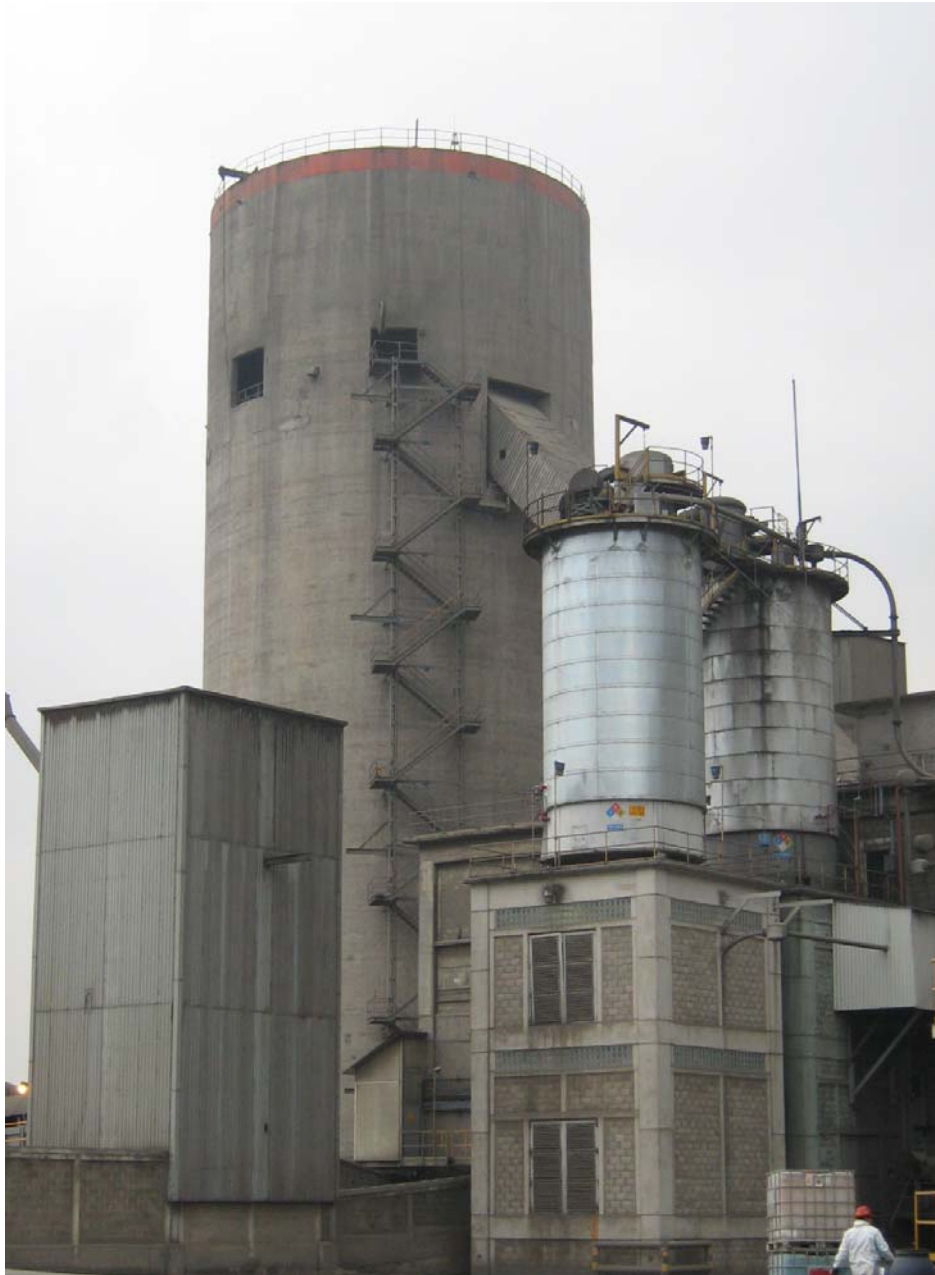
Figura 2.1 Vista general del Silo de Clinker
