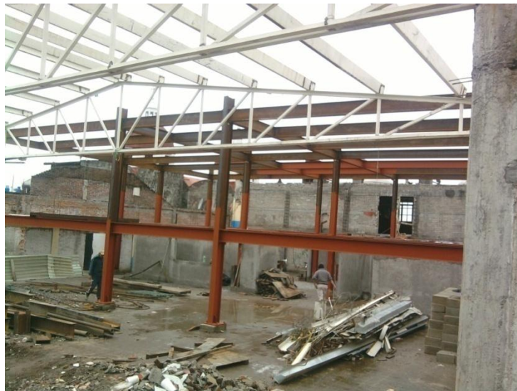
Figura 2.2. Construcción de la Casa de cultura San Pedro Atlapulco, septiembre 2011.
