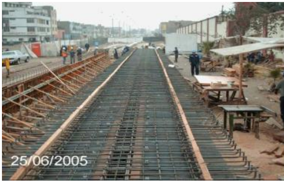
COLOCACIÓN DE ACERO SUPERIOR
