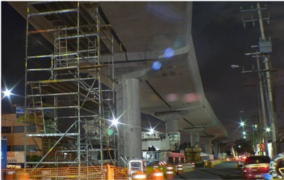
Viaducto elevado de cinco kilómetros de extensión, que albergará cuatro estaciones de la línea dorada.
