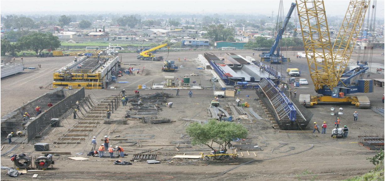
Elaboración de traveses y columnas prefabricadas en planta
