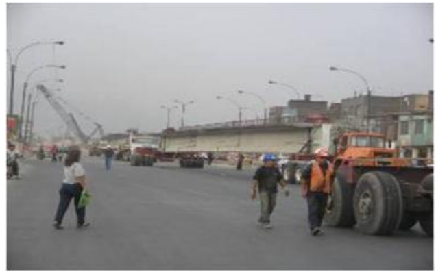
TRANSPORTE DE VIGA CON TRACTO Y PATÍN TRASERO
