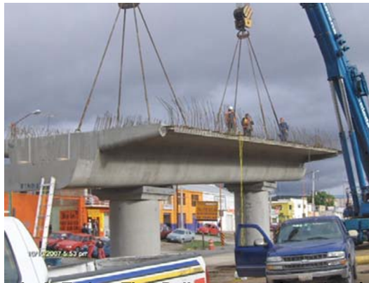
Montaje de Trabes Tipo Ballena con grúas telescópicas
