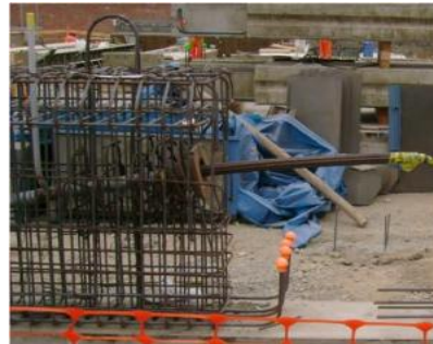
Acero de Refuerzo
