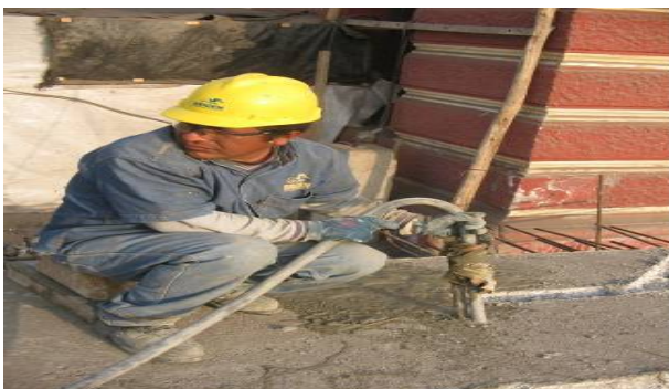
RELLENO DE MORTERO LÍQUIDO
