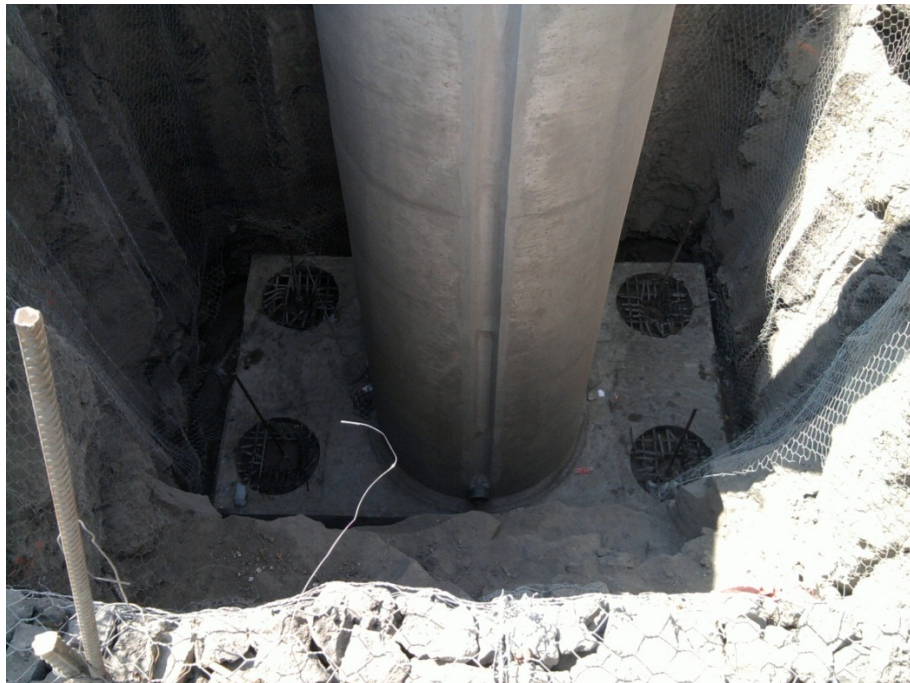
Barras de presfuerzo columna prefabricada
