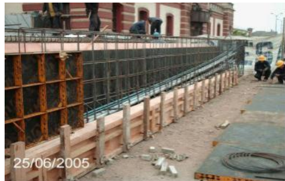
COLOCACIÓN DE CIMBRA 2da CARA
