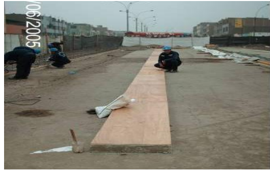
ENCOFRADO DE FONDO DE VIGA
