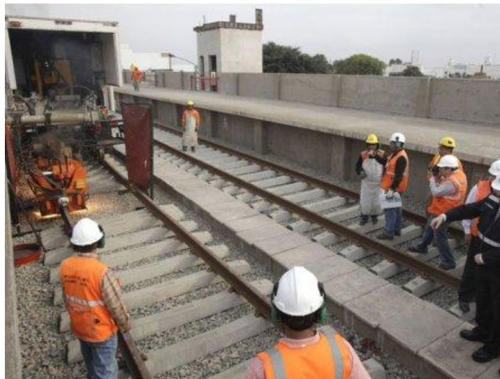
Colocación de durmientes con rielera
