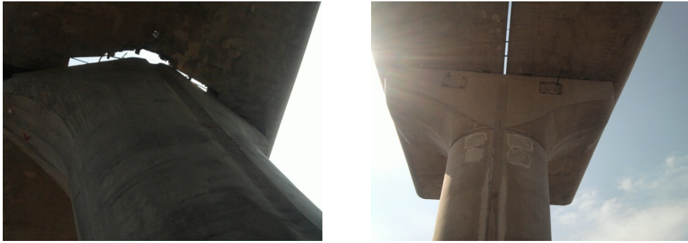
Conexión de trabe columna prefabricada
