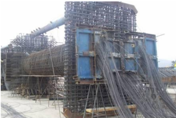
Armado de acero de refuerzo y torones en columna prefabricada
