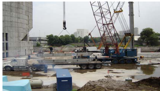
Montaje con Grúas Estructurales.
