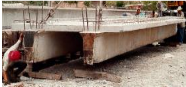
Apoyos en almacenaje de trabes doble T
