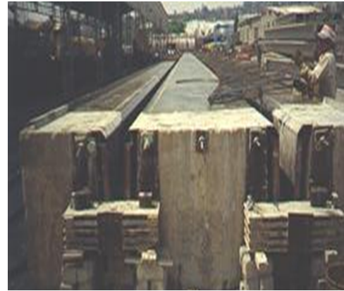
Molde y mesa de colado de concreto presforzado para traveses doble T
