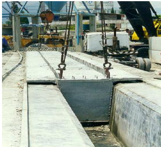
Desmolde de trabe cajón
