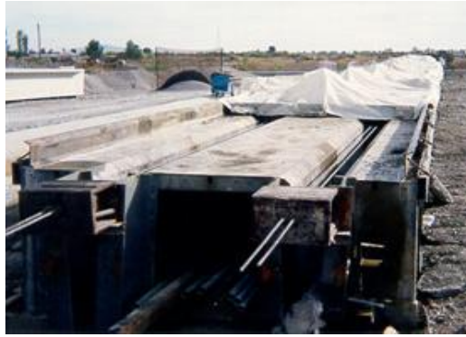
Vista de elementos curados a vapor
