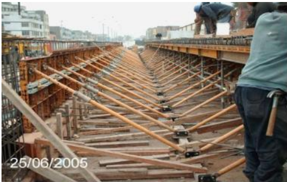
APUNTALAMIENTO DE LA CIMBRA
