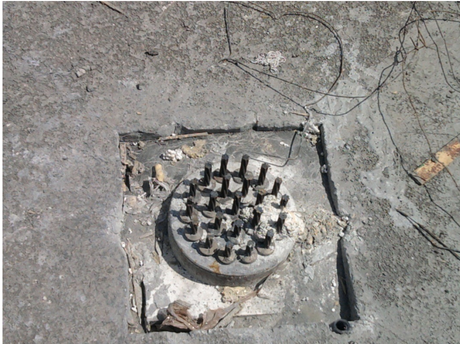
Torón inyectado y tensado en nodo trabe columna
