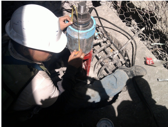
Tensado de anclajes en pila zapata
