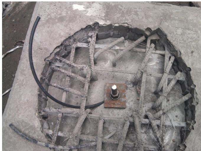
Placa tuerca y manguera de inyección
