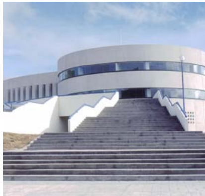
Edificio ejecutado con prefabricados de concreto presforzado.
