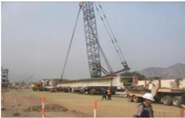
TRANSPORTE DE VIGA CON TRACTO Y PATÍN TRASERO
