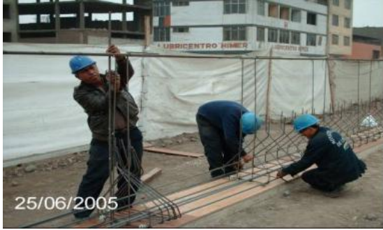
COLOCACIÓN DE ACERO DE REFUERZO
