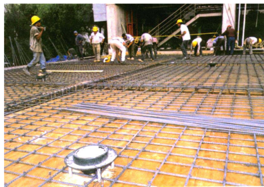
Losa maciza en proceso de construcción
