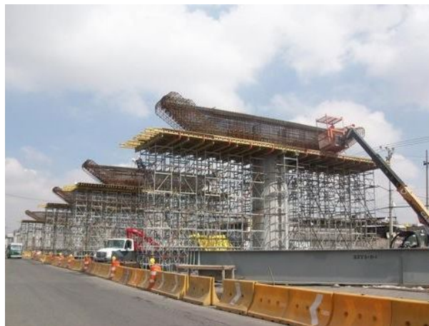
ARMADO DE TRABE VIADUCTO ELEVADO LINEA 12
