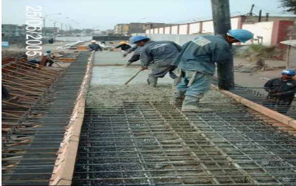
VACIADO Y VIBRACIÓN DEL CONCRETO
