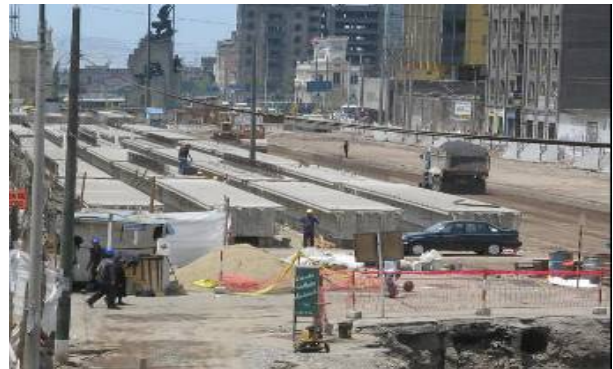
ALMACENAJE DE VIGAS
