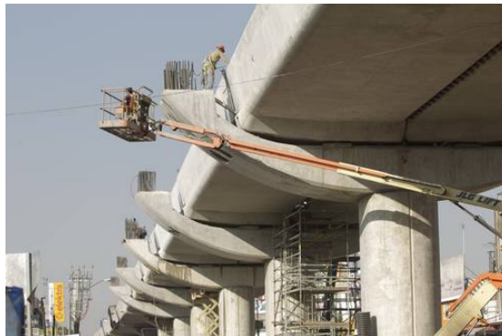
Viaducto elevado línea 12 del metro
