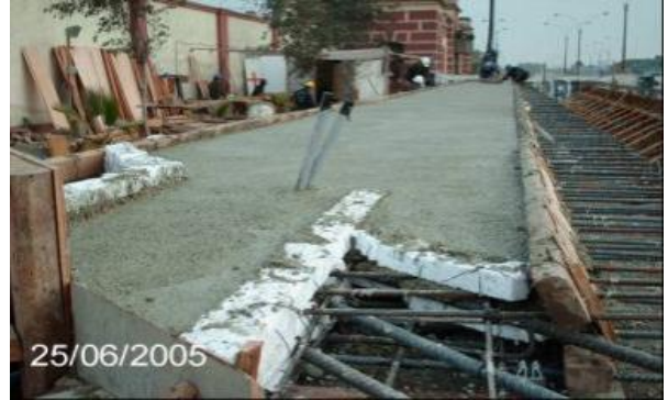
VACIADO TERMINADO CON DUCTOS PARA INYECCIÓN
