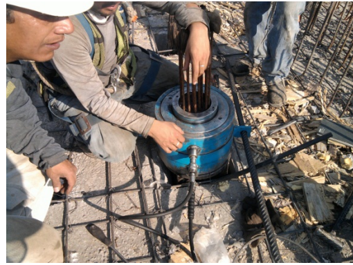
Proceso de tensado con gato hidráulico
