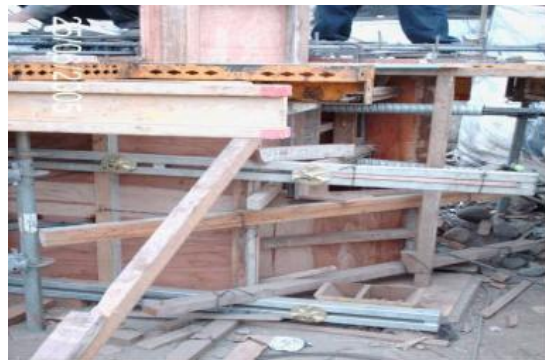
CIMBRA EN ALEROS DE LA TRABE
