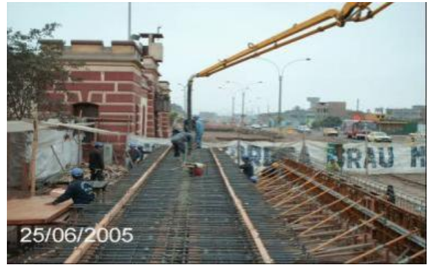
VACIADO DE CONCRETO
