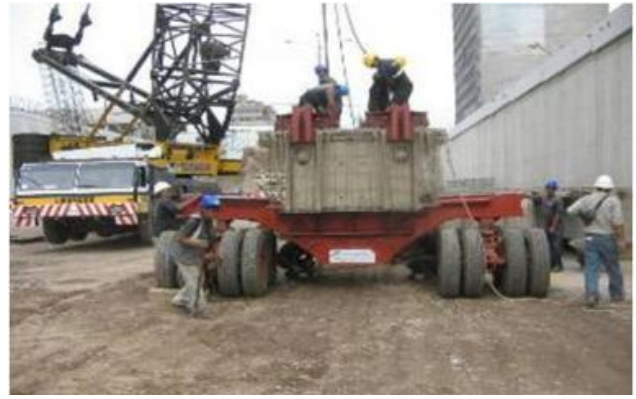
TRANSPORTE DE VIGA CON TRACTO Y PATÍN TRASERO
