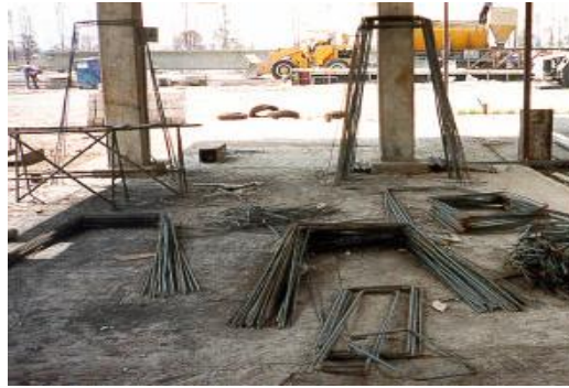
Vista de las instalaciones para almacenaje y preparación de acero en planta
