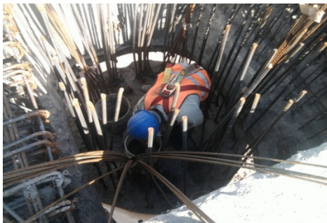
Travesaño columna en su conexión
