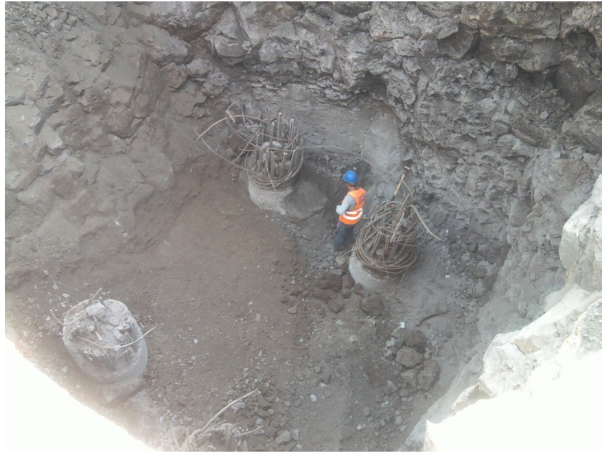
Pilas de cimentación
