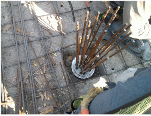
Placa y cuñas para tensado
