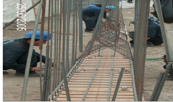
COLOCACIÓN DE ACERO DE REFUERZO
