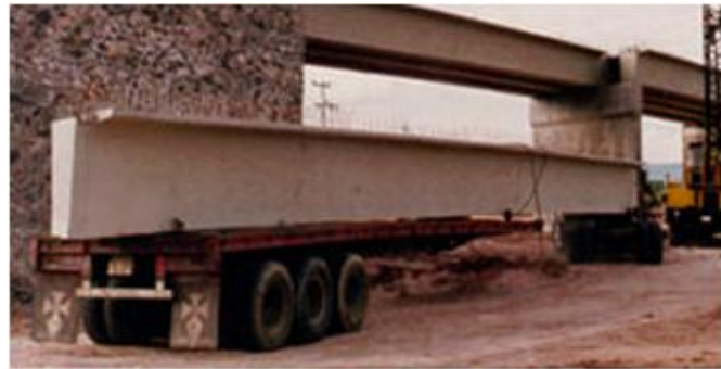
TRACTO CON SEMIRREMOLQUE UNIDO A LA TRABE
