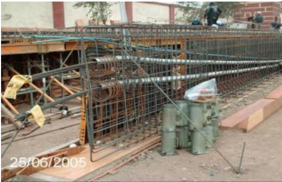
CIMBRA 1ra CARA Y DUCTOS DE POSTENSADO
