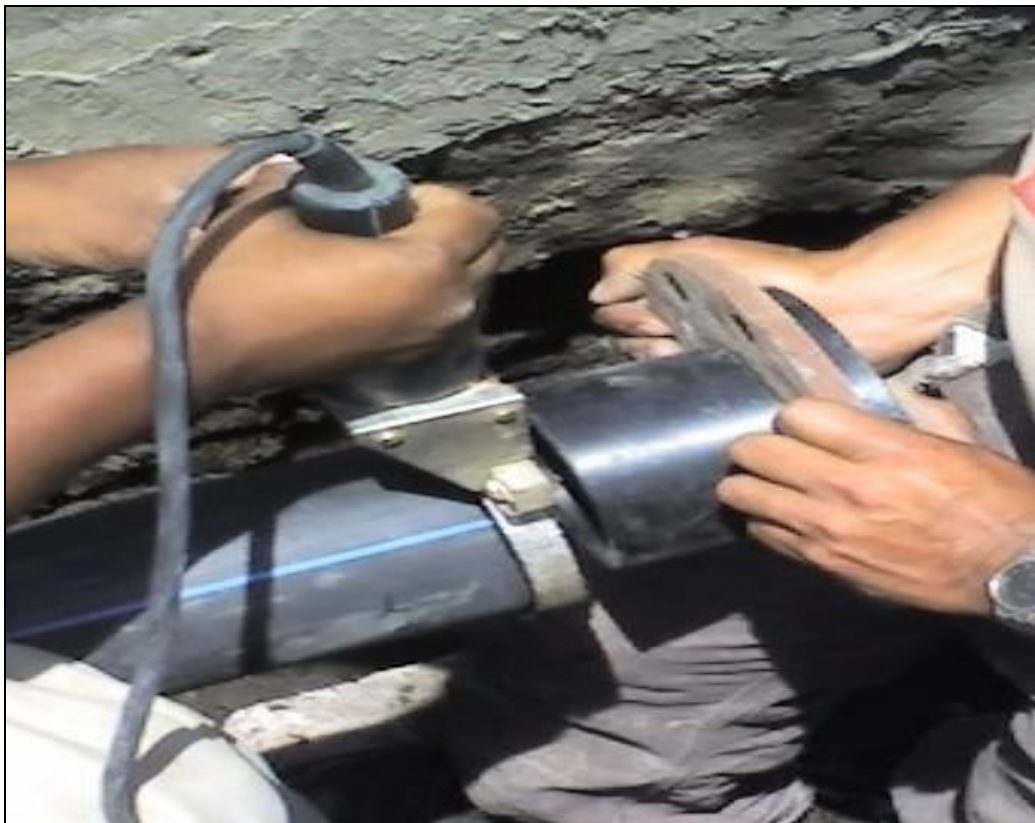
Ilustración 12 Termofusión de la brida y contra brida.
