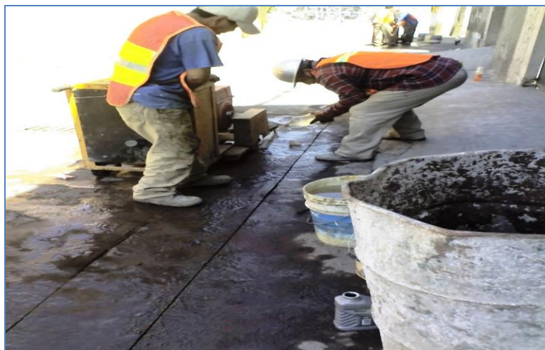
Ilustración 2 CORTE CON SIERRA EN SAN JUAN.
