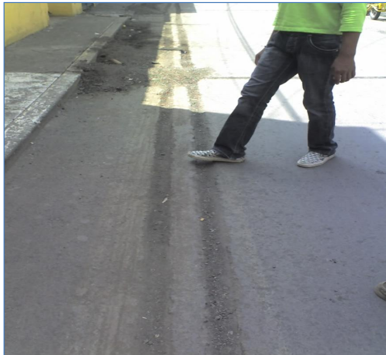
Ilustración 39 CORTE DE ASFALTO EN IGNACIO ALLENDE.
