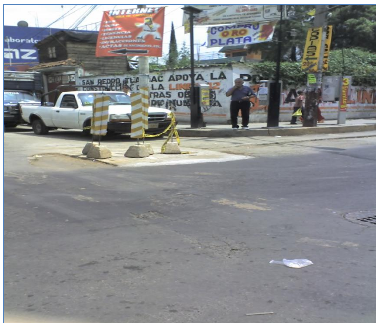
Ilustración 33 SE CONSTRUYE CAJA TIPO 2-2-A EN TLÁHUAC-TULYEHUALCO.
