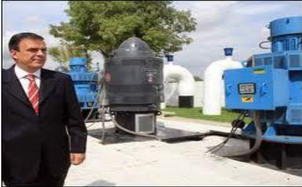
Ilustración 18 Rehabilitación de planta de bombeo.
