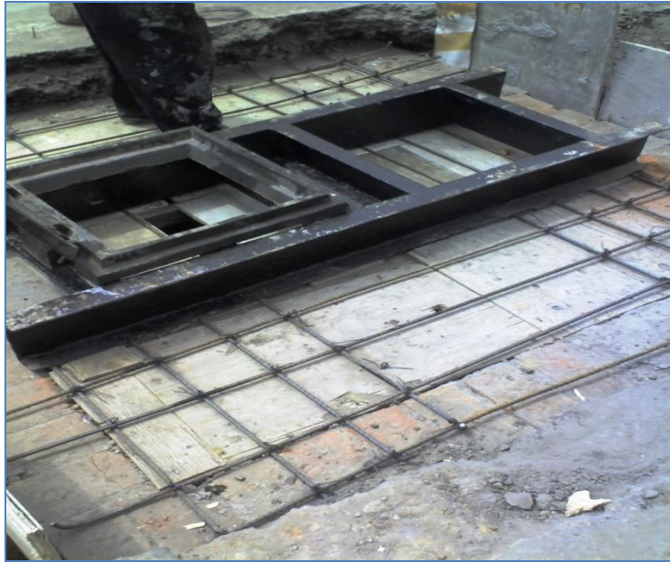
Ilustración 9 CONSTRUCCIÓN DE CAJA DE VÁLVULAS EN IGNACIO ALLENDE.
