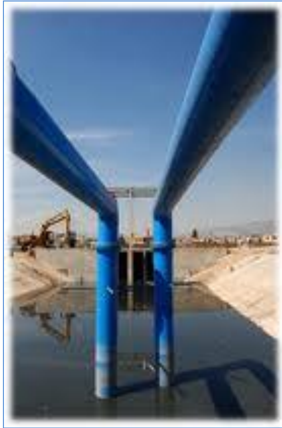
Ilustración 19 Planta de bombeo Canal de Sales.
