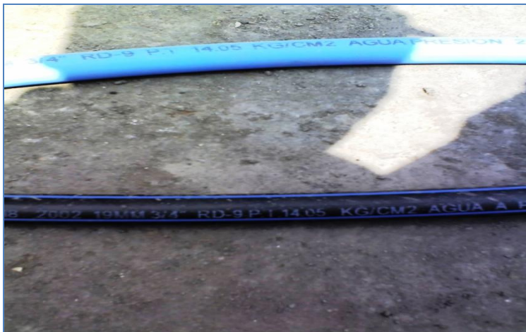
Ilustración 22 SUSTITUCIÓN DE RAMALES EN DIFERENTES FRENTES.
