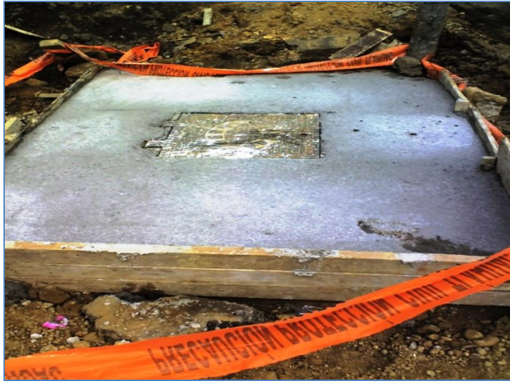
Ilustración 13 CINTA PREVENTIVA EN EL COLADO DE LA LOSA TAPA.
