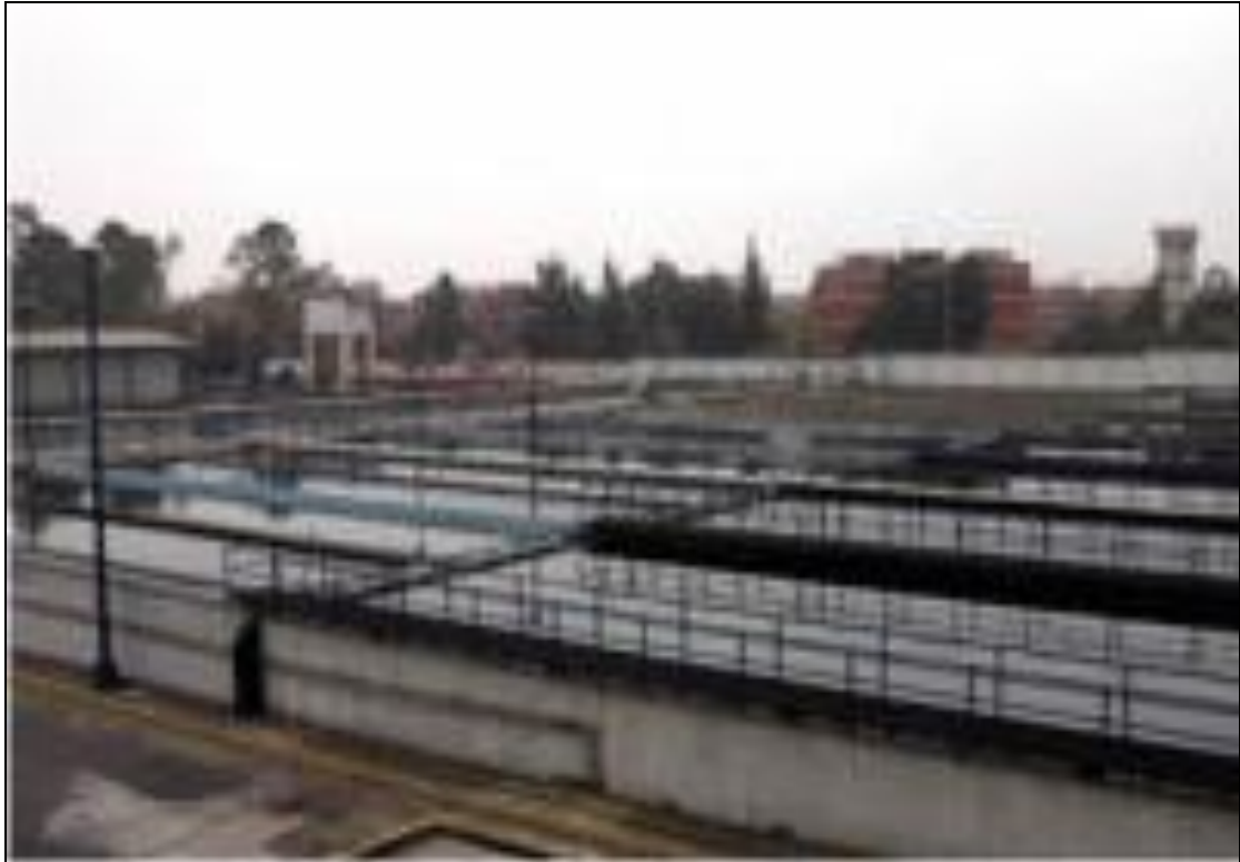
Ilustración 14 planta potabilizadora del cerro de la estrella.
