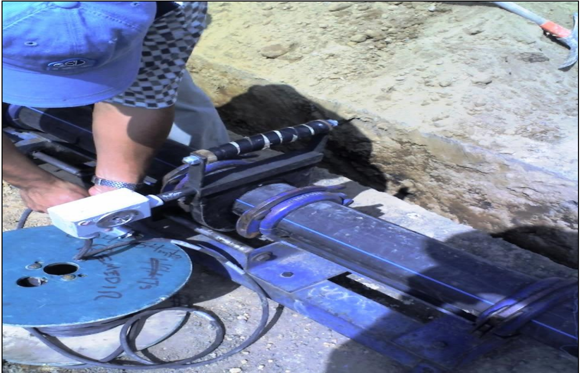
Ilustración 1 Se calientan las superficies del tubo para unirse posteriormente
