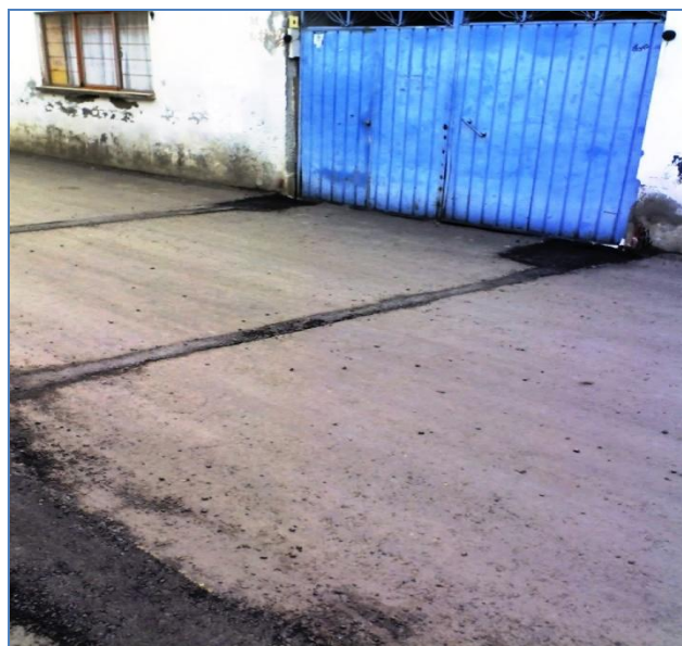
Ilustración 18 BACHEO DE ZANJAS EN GALEANA.
