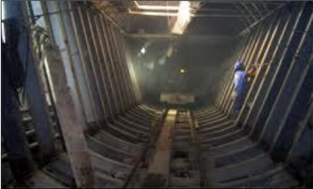
Ilustración 13 Empieza la construcción del Drenaje Profundo.
