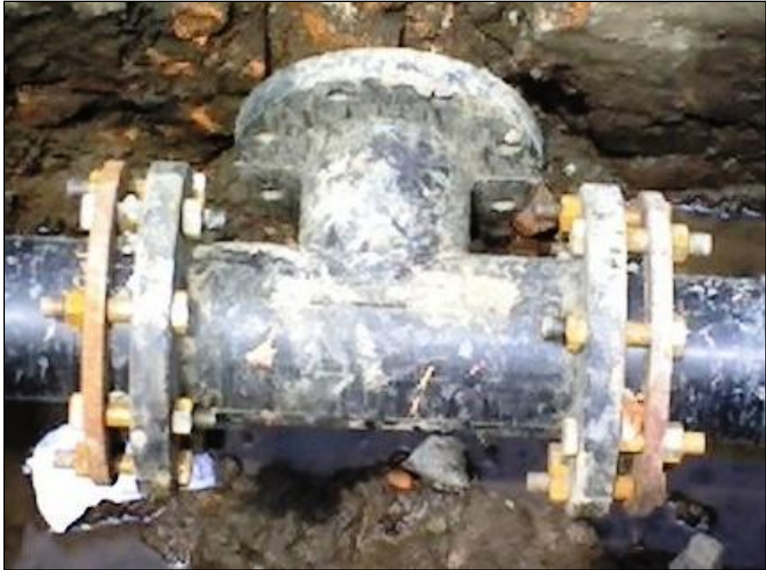
Ilustración 11 Tornillos de cabeza hexagonal que se utilizaron para unión de piezas especiales.
