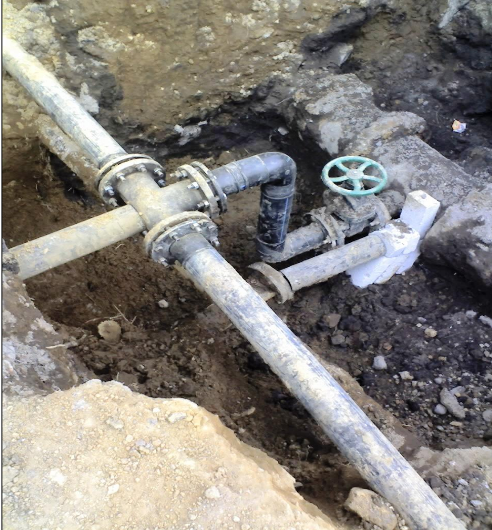
Ilustración 14 Construcción de caja de válvulas en el tramo Tláhuac-Obra ejecutada por la Delegación Tláhuac.
