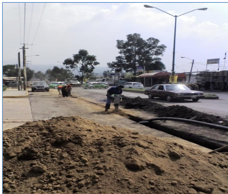
Ilustración 6 RELLENO DE ZANJA EN TLÁHUAC-TULYEHUALCO.
