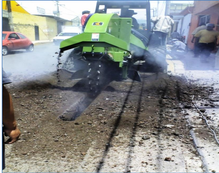
Ilustración 3 DEMOLICIÓN DE PAVIMENTO EN HIDALGO.
