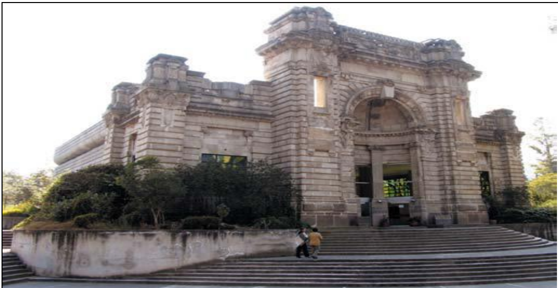
Ilustración 3 casa de bombas " La Condesa " Tlalpan, ciudad de México
