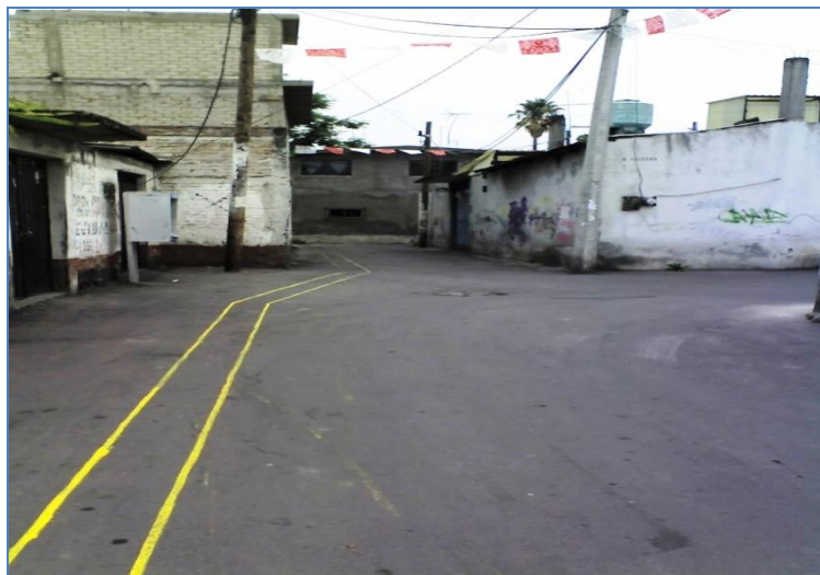
Ilustración 1 TRAZO DE EJES EN EL CALLEJÓN DE SAN JUAN.
