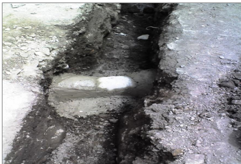
Ilustración 43 REPARACIÓN DE ALBAÑAL EN AV.TLÁHUAC.
