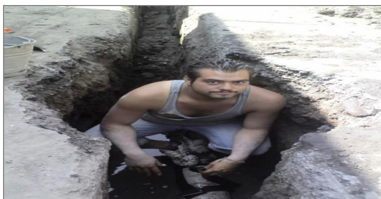
Ilustración 40 DAVID REPARANDO TUBO EN ALLENDE.
