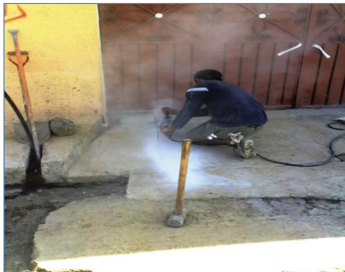
Ilustración 14 CORTE CON SIERRA DE VENTANAS.
