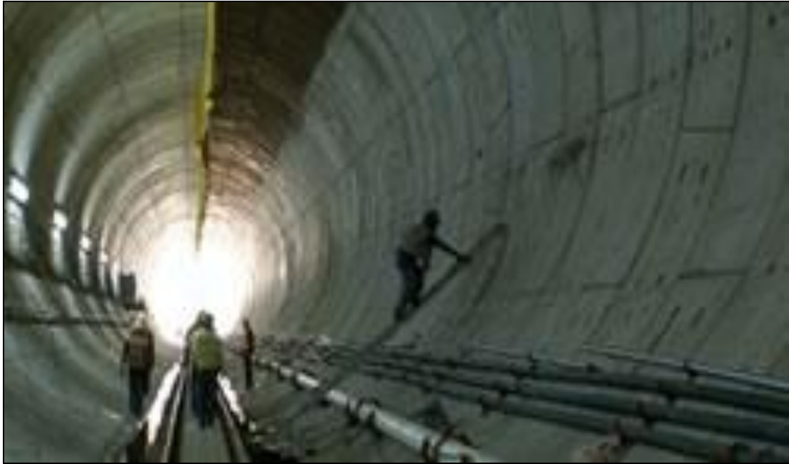
Ilustración 15 construcción de acueducto perimetral.
