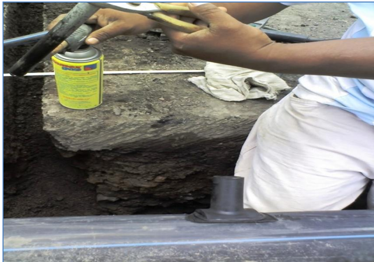
Ilustración 21 REHABILITACIÓN DE TOMAS EN AV. TLÁHUAC.
