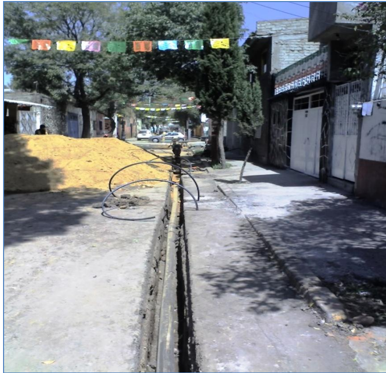
Ilustración 7 TENDIDO DE TUBERÍA EN IGNACIO ALLENDE.
