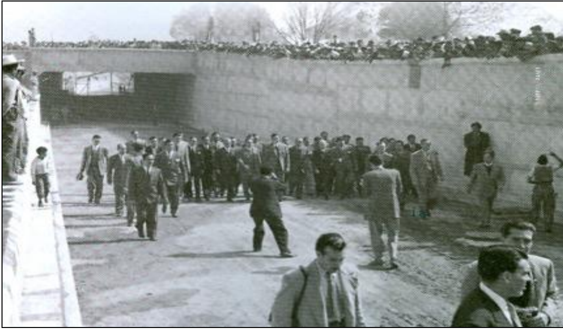
Ilustración 11 Viaducto río de La Piedad.
