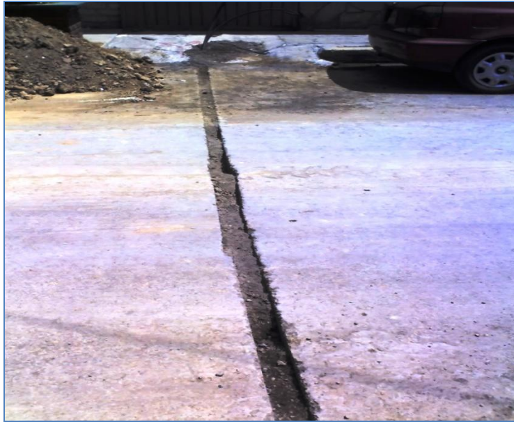
Ilustración 17 RELLENO DE ZANJAS EN HIDALGO.
