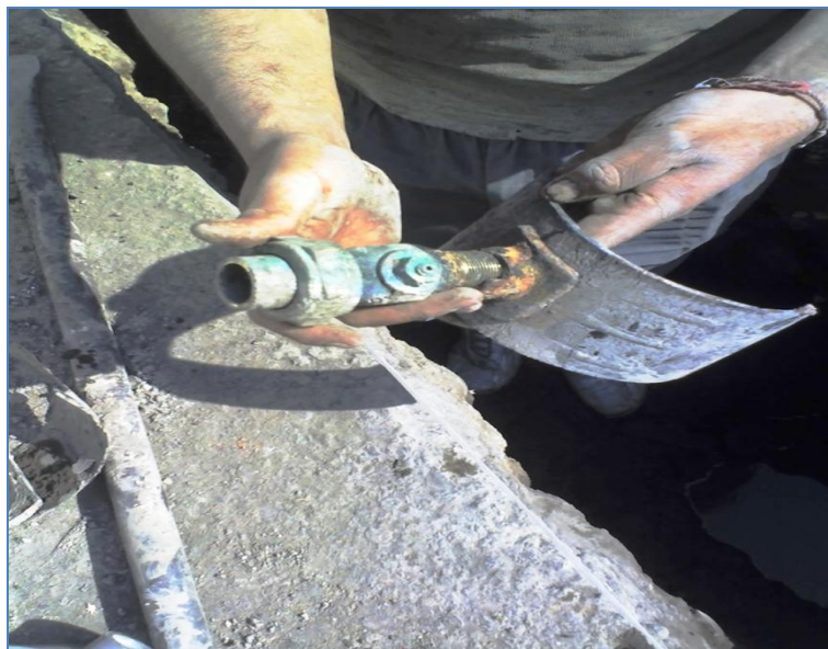
Ilustración 10 TRABAJOS REALIZADOS EN TODOS LOS FRENTES.
