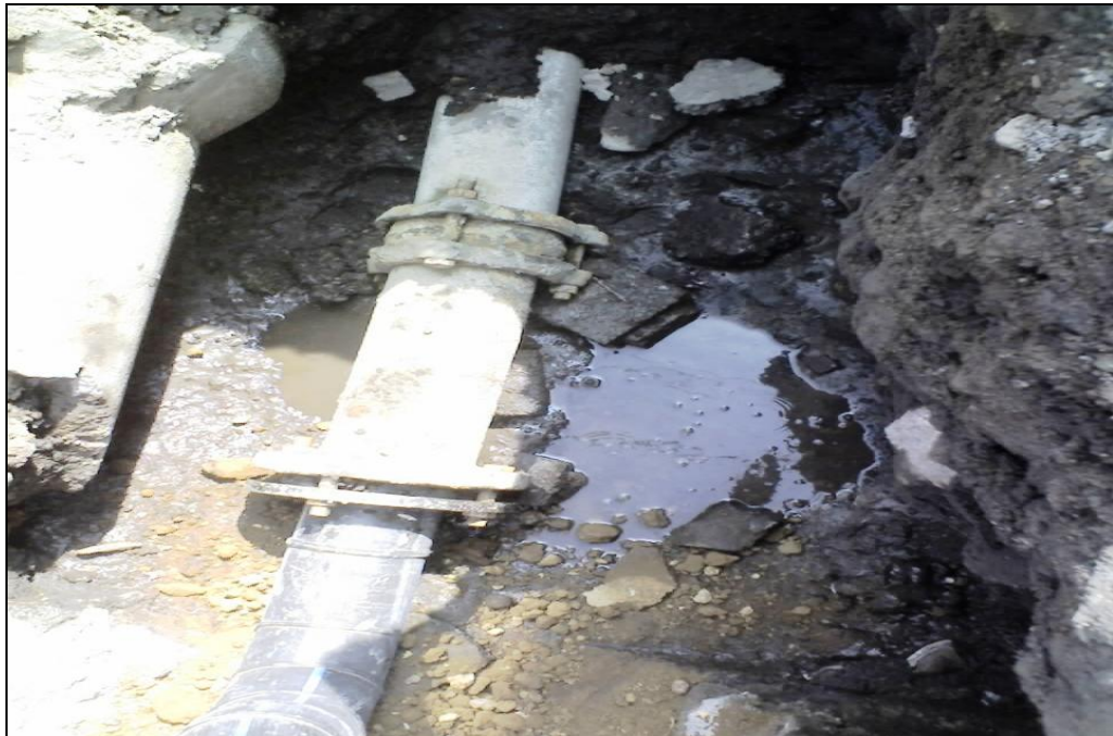
Ilustración 5 Extremidad de fofó para acoplamiento
