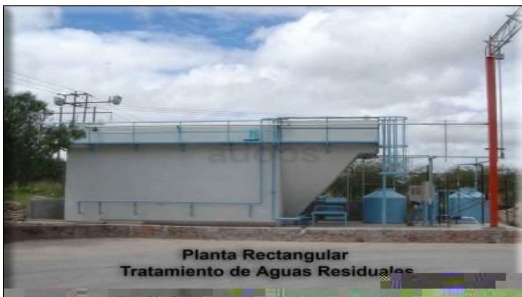
Ilustración 24 Rehabilitación de la planta de tratamiento de aguas residuales Coyoacán.
