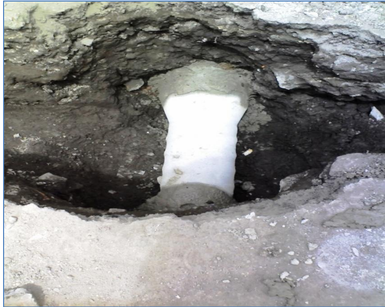
Ilustración 11 REPARACIÓN DE ALBAÑALES EN DIFERENTES FRENTES.
