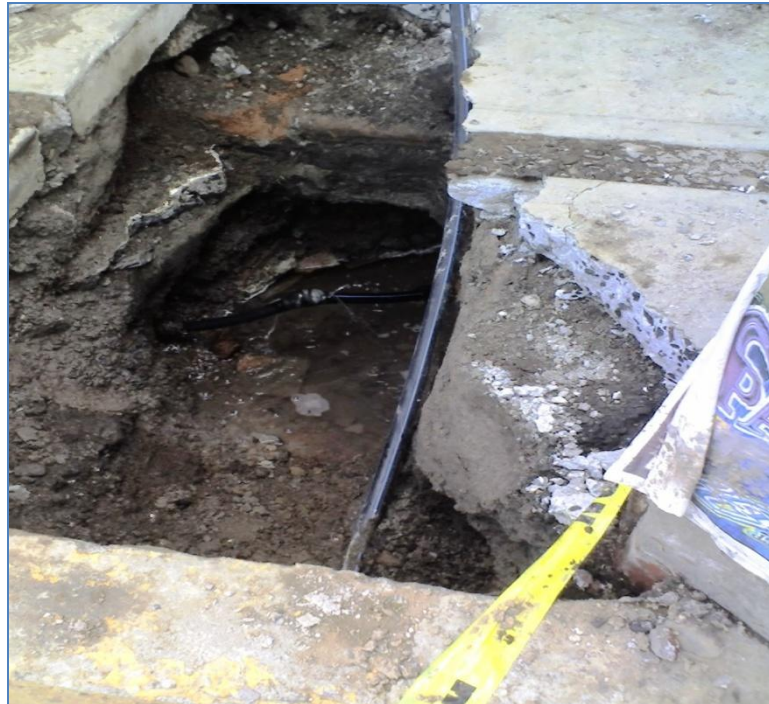
Ilustración 16 EXCAVACIONES PARA UBICAR LAS TOMAS.
