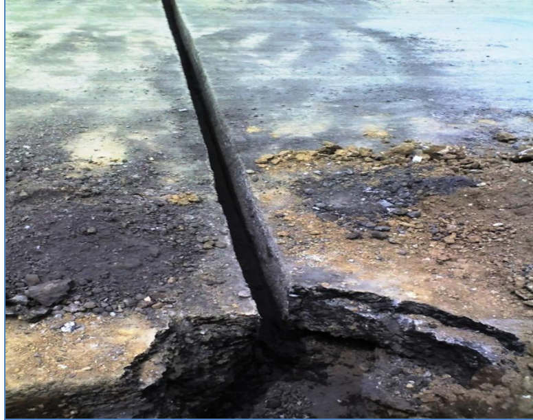
Ilustración 15 ZANJAS PARA REHABILITAR LOS RAMALES.
