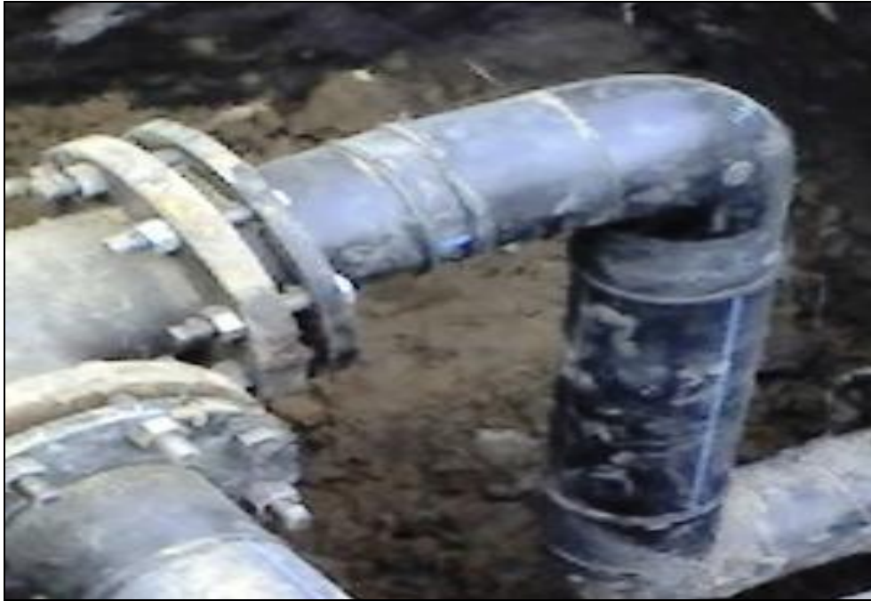
Ilustración 13 Codo de 90 grados de PEAD.
