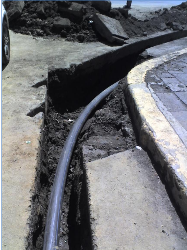
Ilustración 36 TERMOFUSIÓN DE TUBO PEAD EN HIDALGO Y AV. TLÁHUAC.
