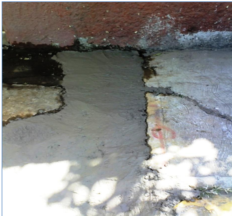
Ilustración 20 REPOSICIÓN DE BANQUETA EN ALLENDE.
