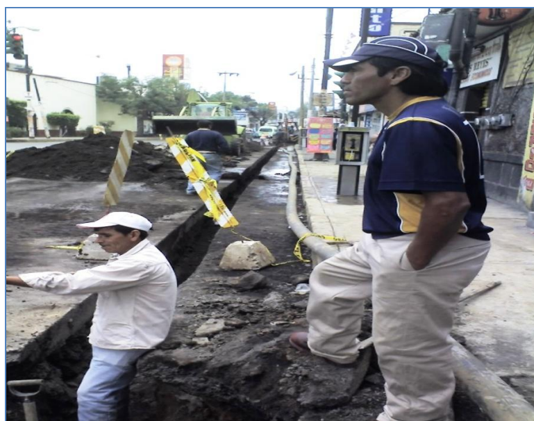
Ilustración 4 EXCAVACIÓN EN AV. TLÁHUAC.
