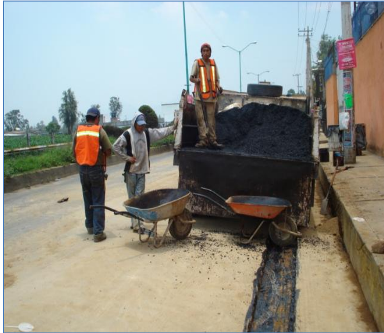
Ilustración 19 ACARREO DE CONCRETO ASFÁLTICO EN DIFERENTES FRENTES.
