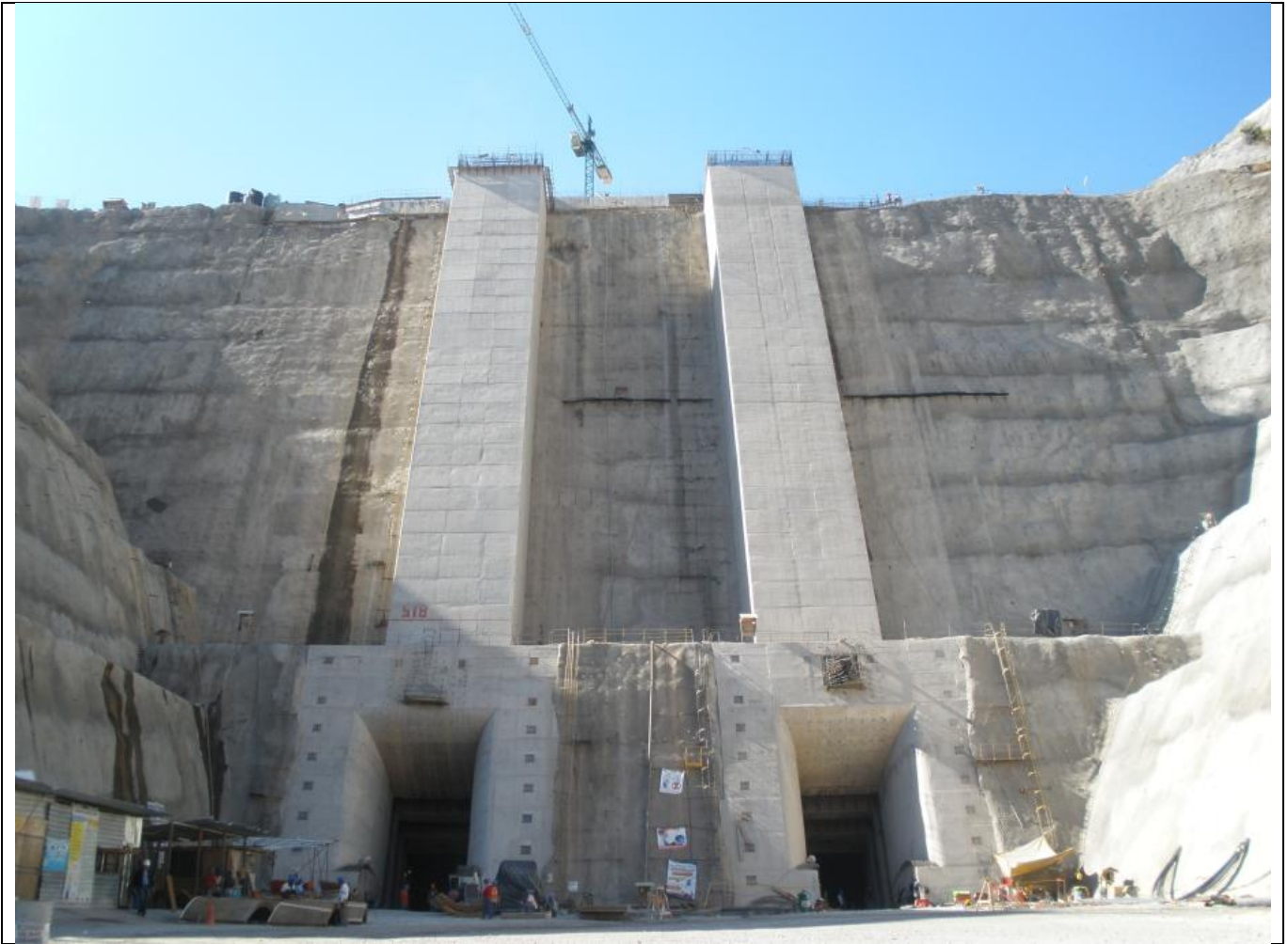
Fuente: Elaboración Propia. Figura 53, Vista de la Obra de Toma
