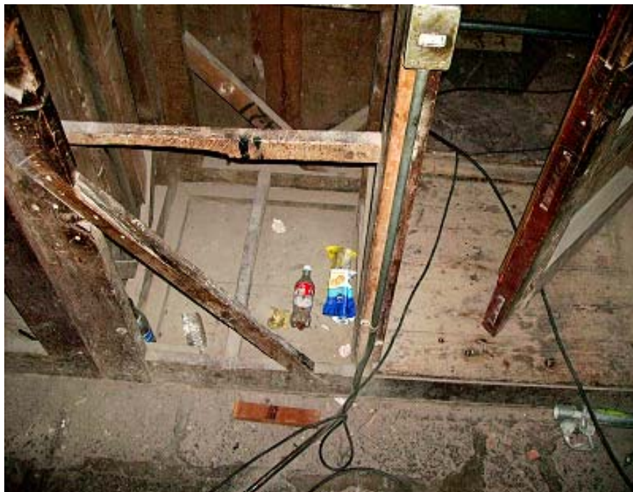
Figura 40. El casi nulo mantenimiento ha traído como resultado la acumulación de basura
