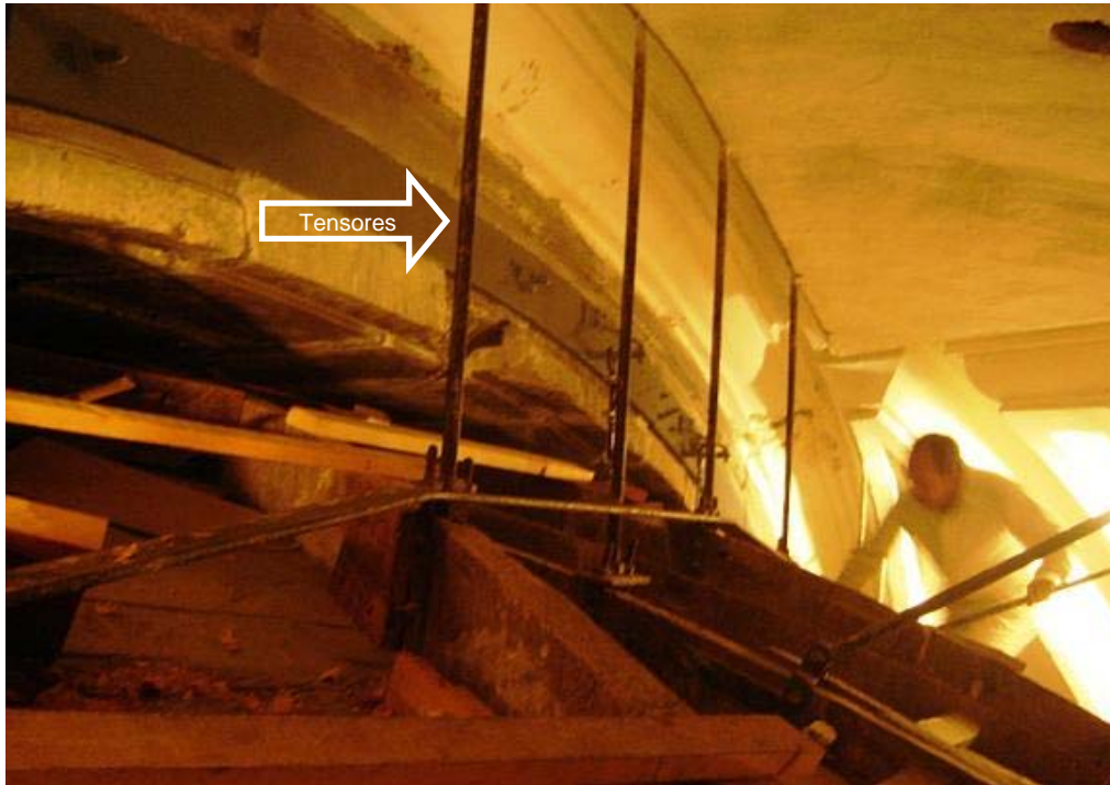
Figura 33. Tensores metálicos rígidos que ligan la concha a la bóveda del ábside
