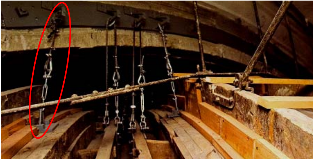
Figura 38. Tensores ajustables en el extradós de la concha
