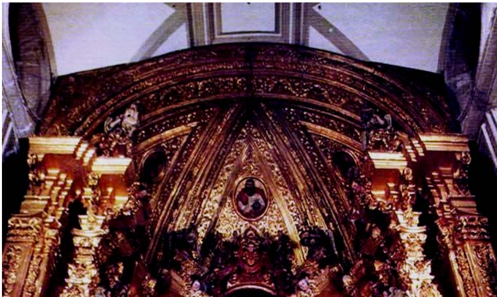
Figura 5. Vista del intradós del remate con forma de cocha
