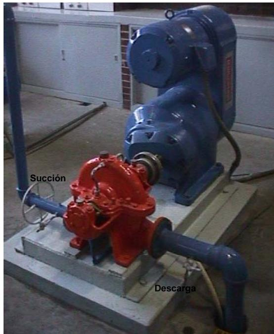
Figura 4.1. Instalación de la bomba de flujo radial. Rango de operación de 1440 a 3280 rpm, potencia 15 HP.
