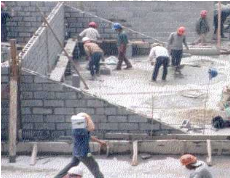
Fotografía 1. Construcción de muros de block. Fuente: Elaboración propia.
