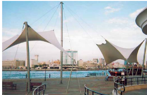
Figura 2.16. Red de cables con diversos puntos altos
