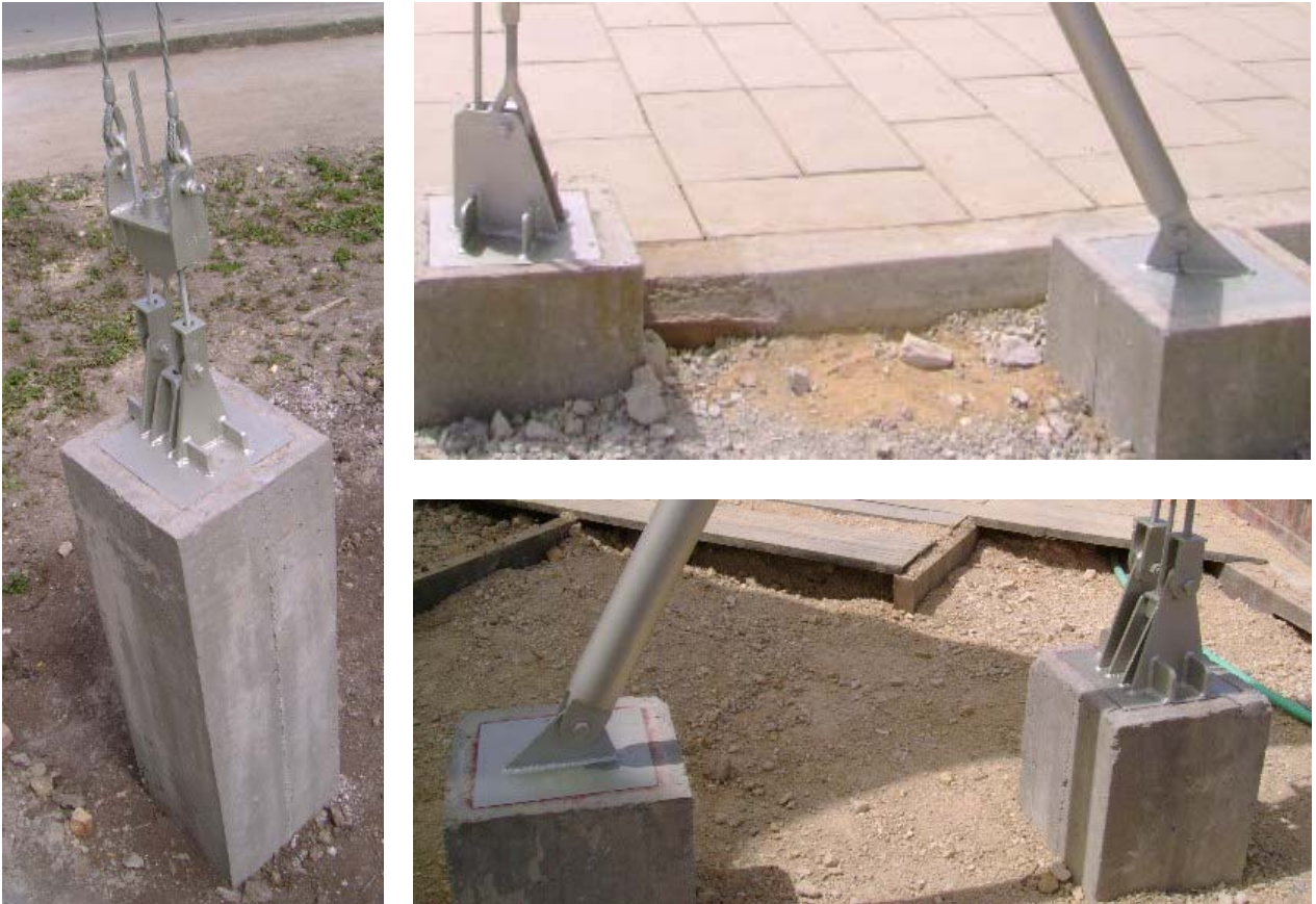
Figura B.14. Algunos de los anclajes de la velaria
