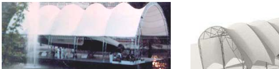
Figura 2.10. Red de cables entre arcos verticales Fuente: Ref. 22
