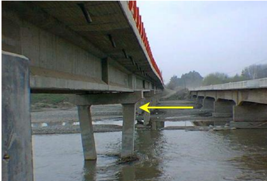
Figura 18. Inclinación de pila del Puente Naltahua, 2002
