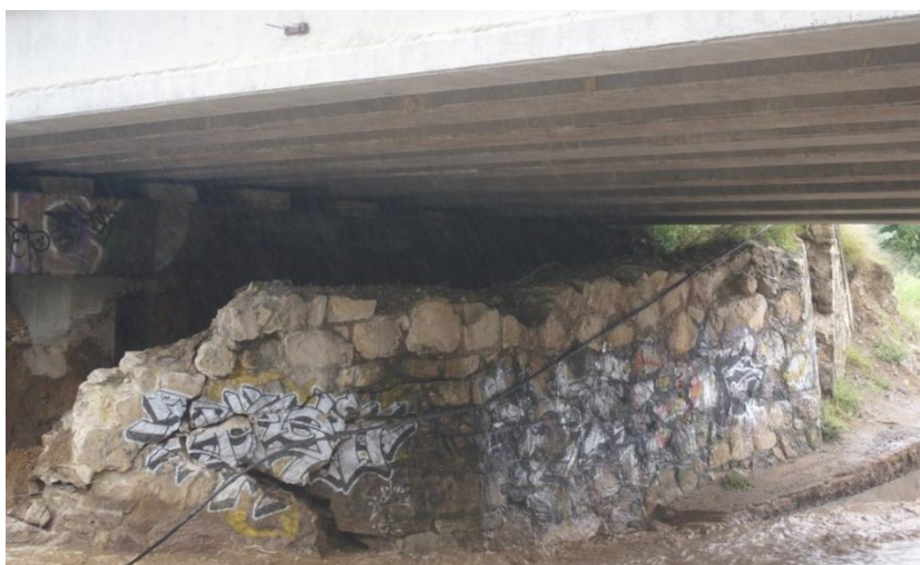
Figura 14. Daños en estribo del puente Macuilxóchitl
