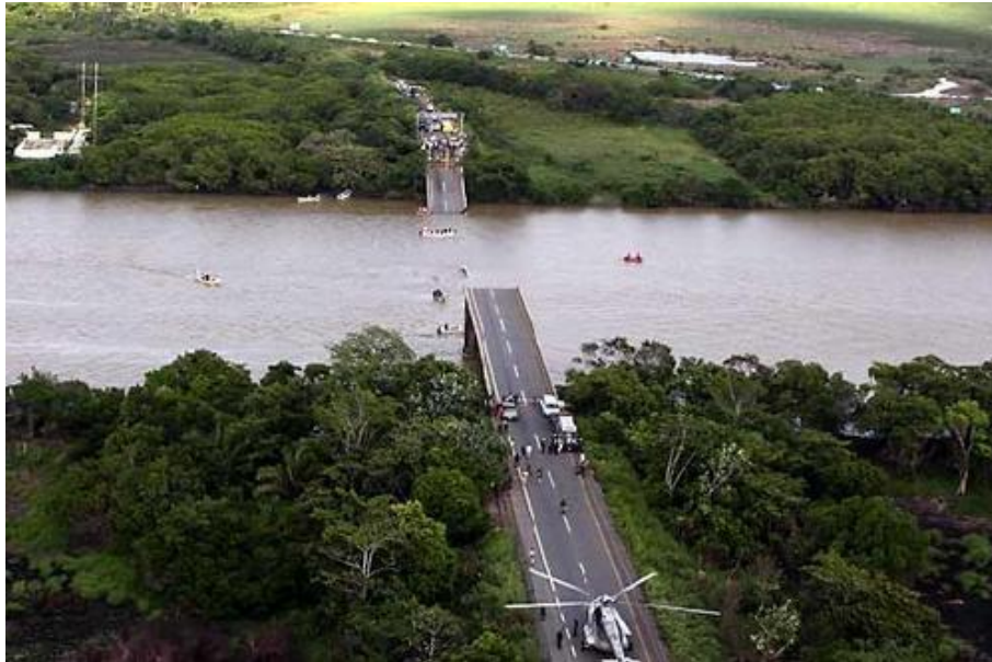
Figura 11. Puente Tonalá en el momento del colapso
