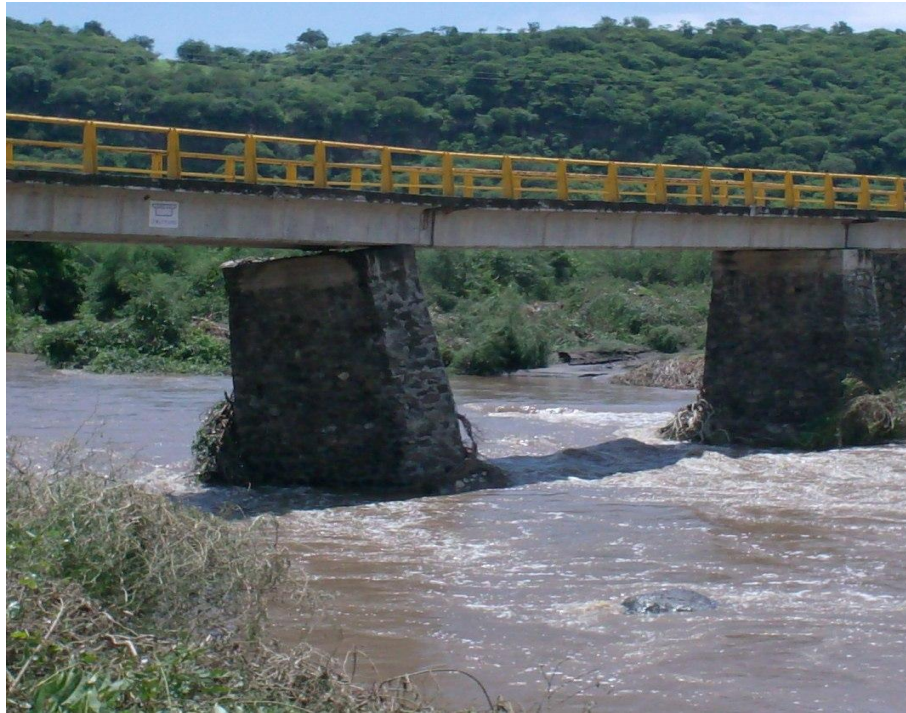
Figura 16. Pila dañada del puente Nexpa
