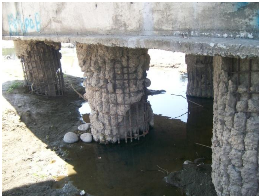
Figura 7. Exposición de la cimentación del puente Pijijiapan I
