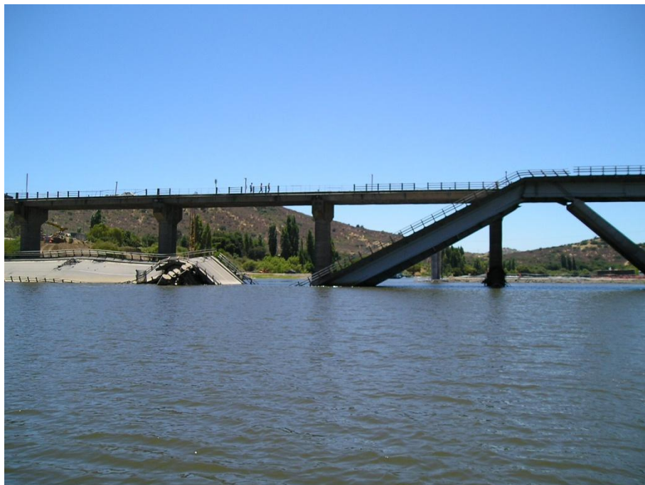
Figura 21. Vista lateral del Puente Loncomilla colapsado
