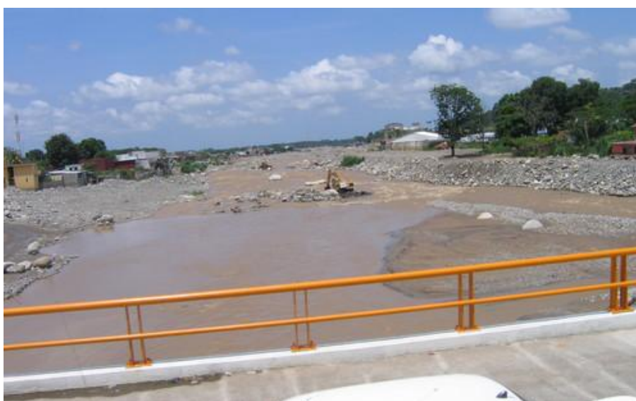
Figura 9. Puente y río Coatán después de la presencia del huracán Stan
