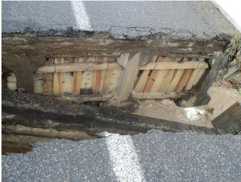
Figura 15. Daño en losa de puente Macuilxóchitl
