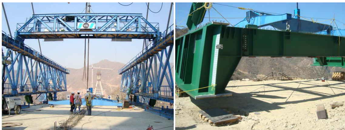
Fig. 3.23 Izado de dovela
