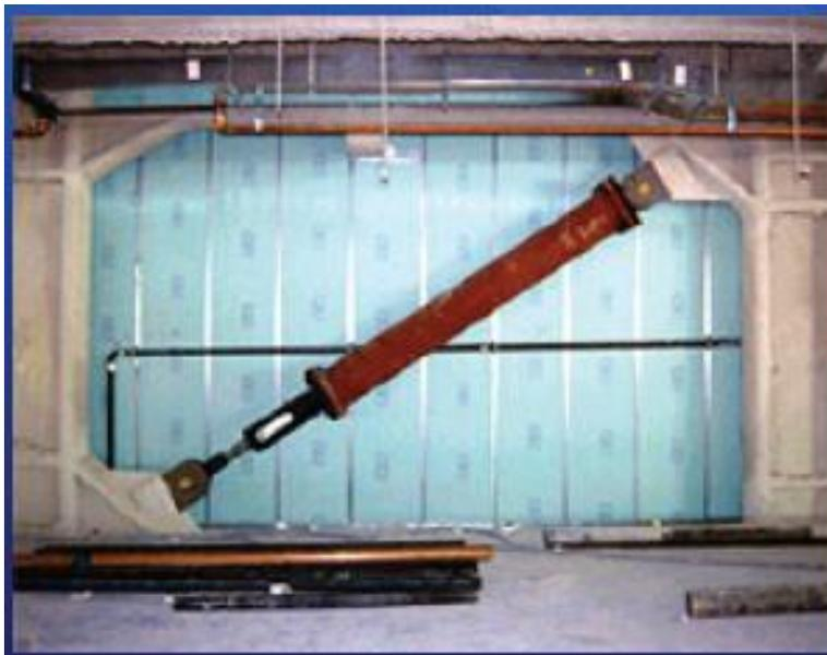
*Figura 4.1: Amortiguador Viscoso (VD).*
