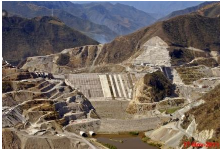
Figura 1.24 Proyecto hidroeléctrico La Yesca. CFE
