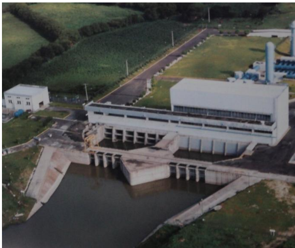
Vista área planta de bombeo
