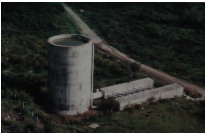
Tanque unidireccional, en el km 5+340 de 23 m de altura y 12 m de diámetro
