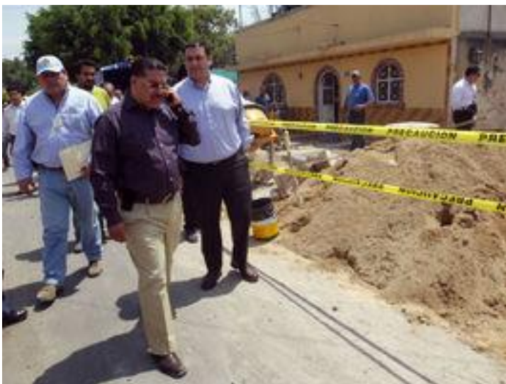
Director del organismo operador del agua SIAPA y el Presidente Municipal de Zapopan, visitando las casas destruidas por la rotura de la tubería en la colonia Balcones de la Cantera, Periódico El Mural Mayo 2011,
