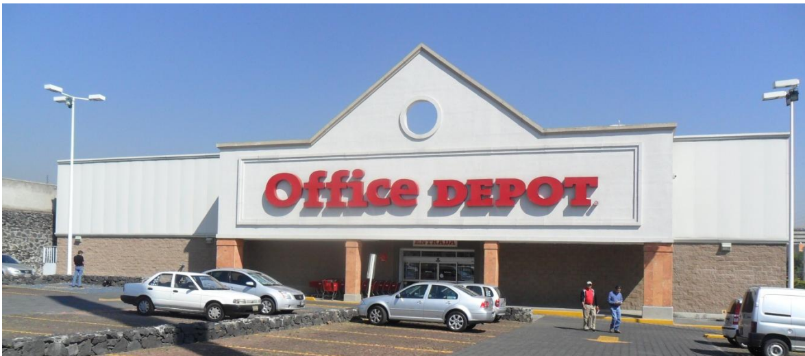
Figura 4-3. Vista de la fachada del inmueble analizado
