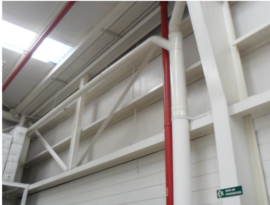
Figura 4-6. Imagen del arreglo que hay en paneles y montenes
