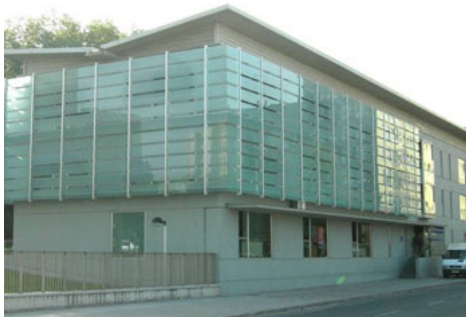
Figura 2.1 Vidrio templado de tipo arquitectónico
