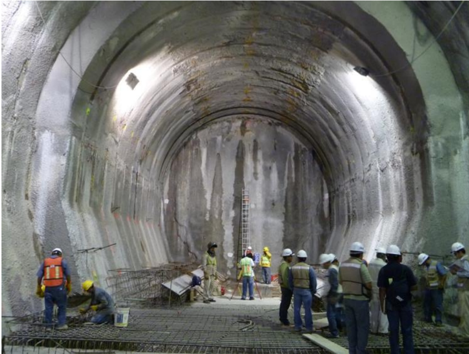
Foto 5. Galería de montaje terminada (lumbreira L-10)
