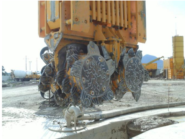
Foto 2. Detalle del cortador de la Hidrofresa
