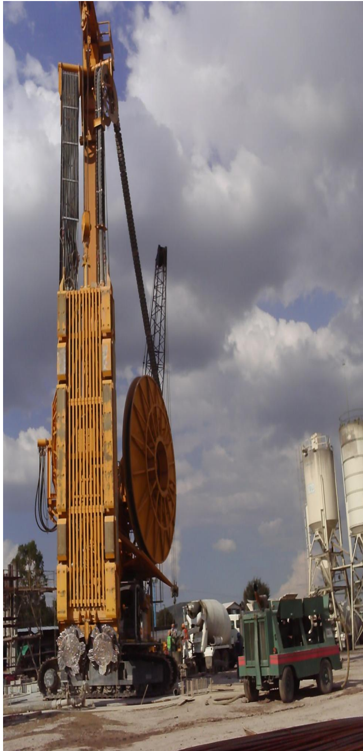
Foto 1. Hidrofresa en la lumbrera L-19
