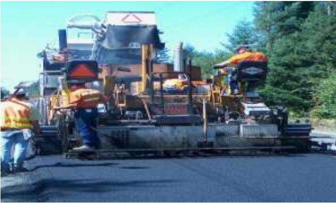
Fig. V.1.- Pavimentadora en operación (Fuente: Constructora CUCSA).
