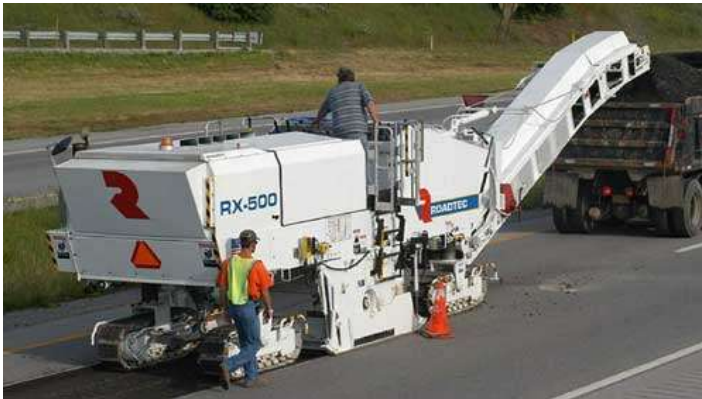
Fig.V.2.- Microfresado de corrección de perfil (Fuente: Pagina web del grupo OHL).
