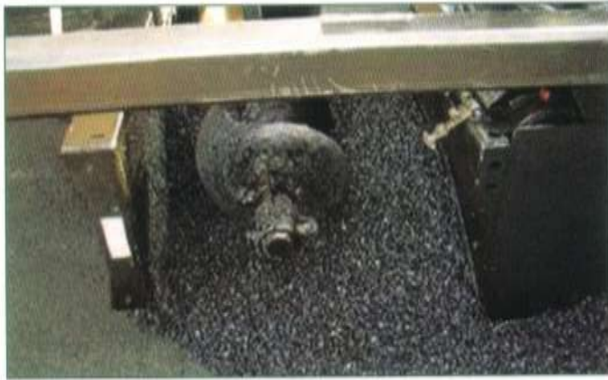
Fig. V.4.- Movimiento de tornillo sinfín de la pavimentadora (Fuente: fotografía propia del autor).
