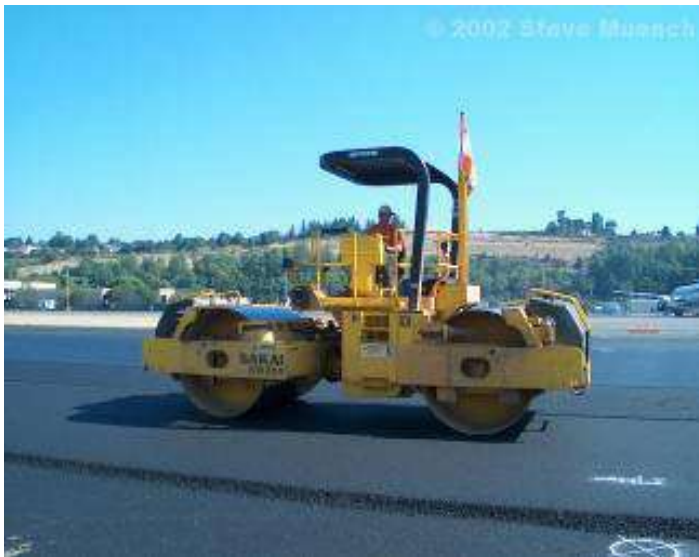
Fig. V.5.- Compactadora tipo rodillo en operación (Fuente: Pagina web de la constructora grupo OHL).
