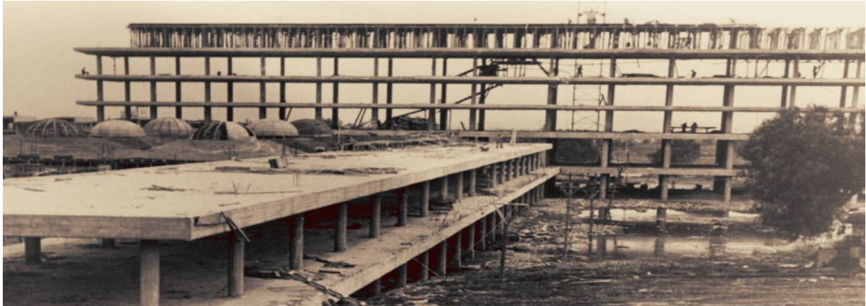
IMAGEN 1.3. EDIFICIO DE LABORATORIOS EN SU CONSTRUCCIÓN (CIUDAD UNIVERSITARIA)
