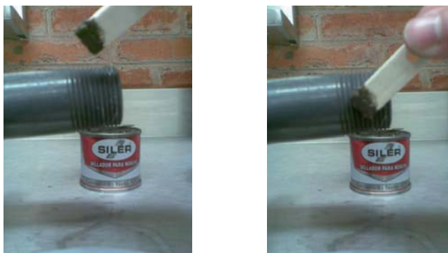
Figura 37: Aplicación de sellador
