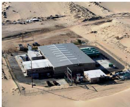
Figura 11: Planta desalinizadora por OI en Los Cabos, BCS
