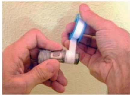
Figura 34: Aplicación de la cinta teflón
