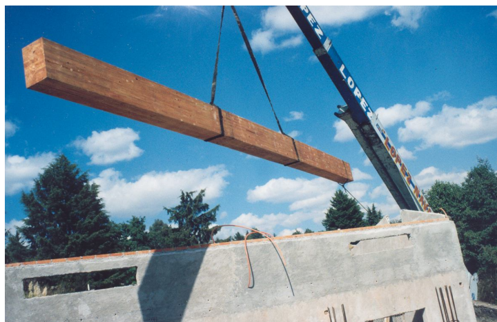
Fig. 4.11 Transporte y montaje.
