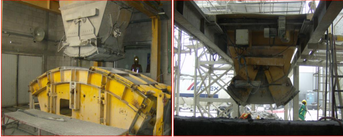
Bacha para concreto con capacidad para 3 m 3
