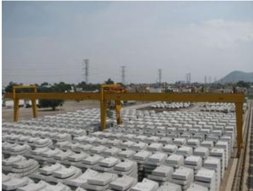
Grúa tipo portal de 50 m de claro, 24 toneladas de capacidad, operada con cabina cerrada a lo largo de 250 m. Ubicada en el patio central de la planta, cuenta con pinza mecánica para tres dovelas
