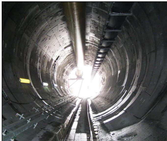
Figura 1.- Túnel con revestimiento a base de dovelas en proceso de construcción. Se observan las múltiples instalaciones de ventilación y energía eléctrica en la parte superior. En la parte inferior un tendido de vías férreas para el suministro de dovelas y transporte de personal al frente de excavación. La foto corresponde al TEO viendo hacia el Portal de Salida, en Hidalgo.
