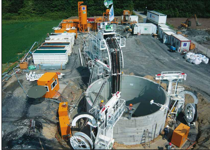
Figura 8.- Implementación del método mecanizado en el proyecto de un túnel de drenaje para el río Emscher, en Alemania. La lumbrera cuenta con un diámetro de 9.0 m y 23.0 m de profundidad.
