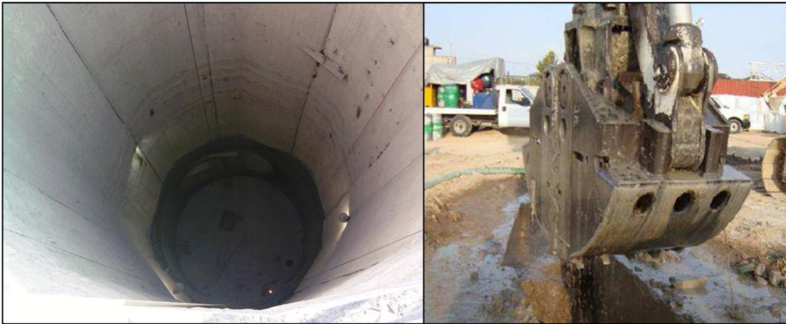
Figura 6.- En la fotografía de la izquierda se muestra el aspecto terminado de la Lumbrera 04 con muro Milán como revestimiento único. En la figura de la derecha se muestra una almeja bivalva accionada mecánicamente haciendo la excavación de un tablero precisamente para alojar al muro Milán. En esta foto también se observa la inundación con lodo bentonítico durante la excavación del tablero.
