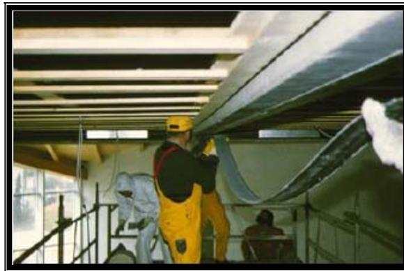
*Fig. 2.5.1 Colocación de refuerzo por flexión*
