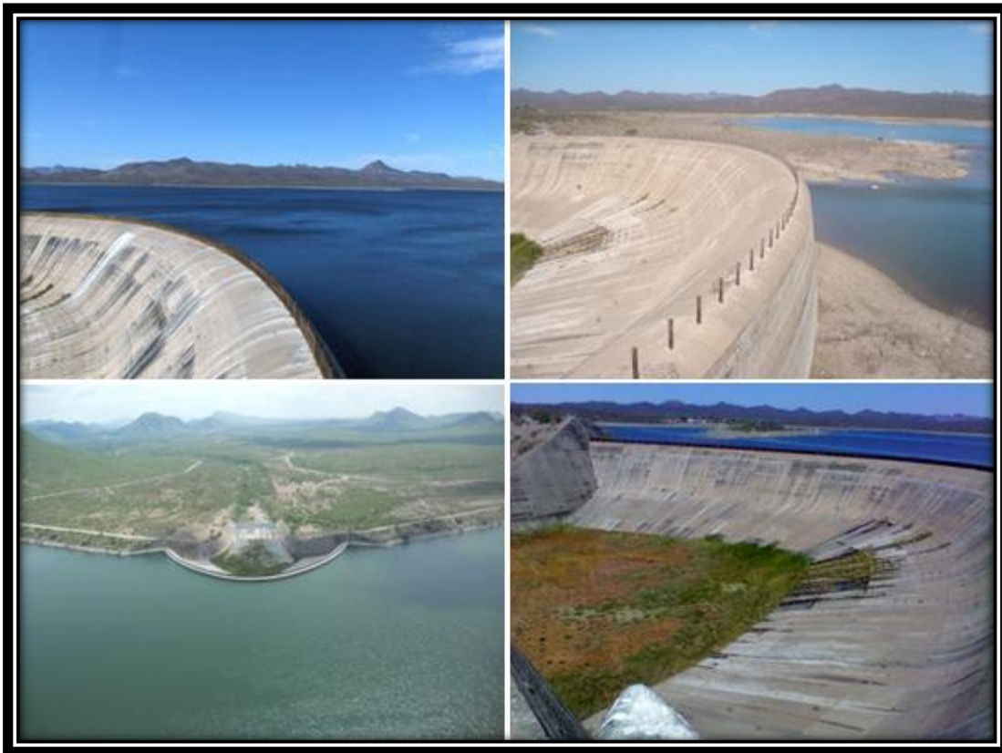
Figura III-4. Vista de la obra de excedencia de la presa El Oviáchic
