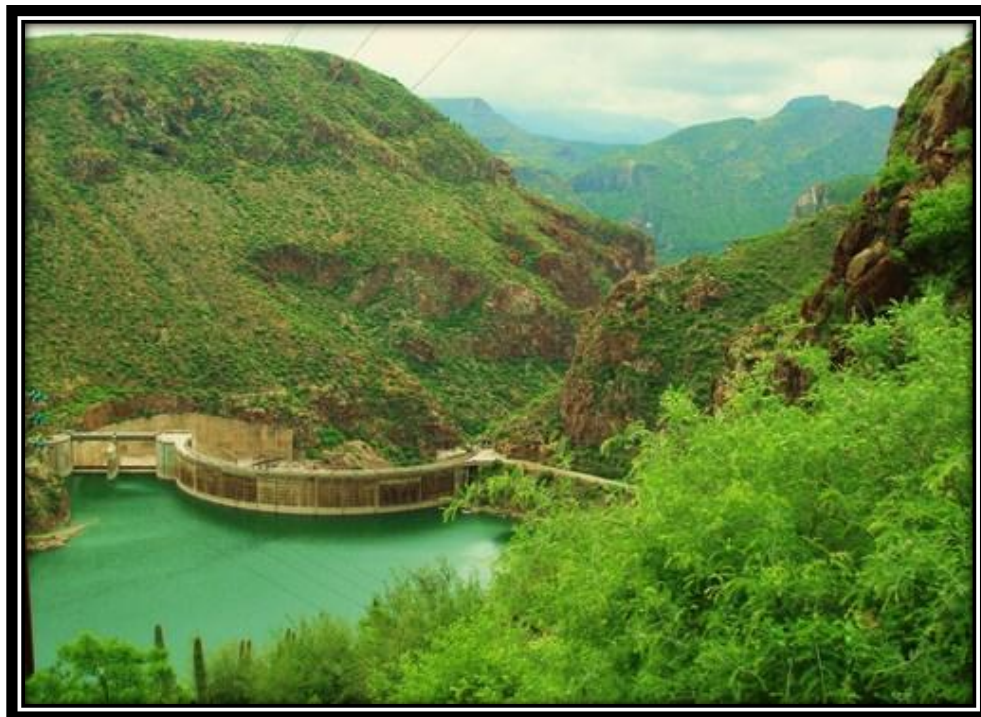
Figura III-2. Vista de la presa La Angostura, Son
