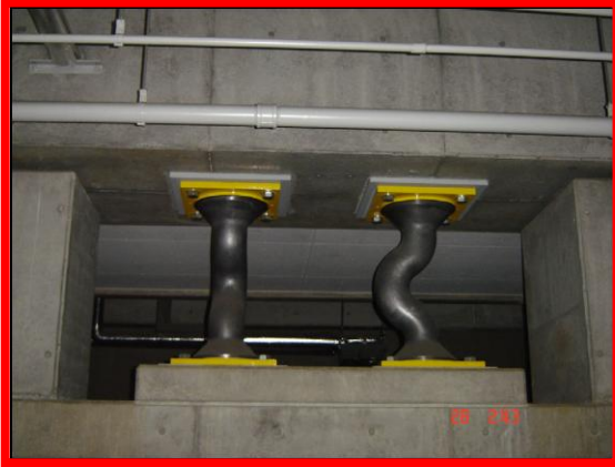
Fotos 1.3 y 1.4. Amortiguadores metálicos. (Revista EIA 2006)
