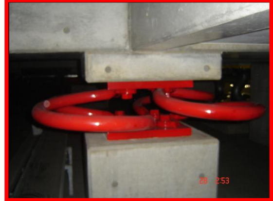
Fotos 1.3 y 1.4. Amortiguadores metálicos. (Revista EIA 2006)
