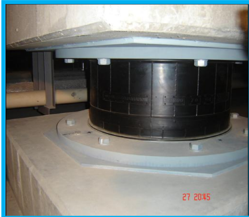
Foto 1.2. Aislador de caucho natural. Figura 1.5. Características internas del aislador elastomérico. (Revista EIA 2006)
