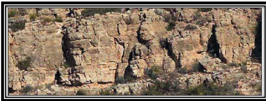
Figura 3.1 Afloramientos con fracturas.
