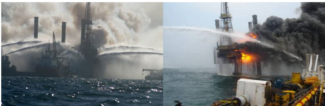
Figura 2.6. Desmantelamiento del piso de perforación y cantilever. (Fuente: Informe Battelle, PEMEX)
