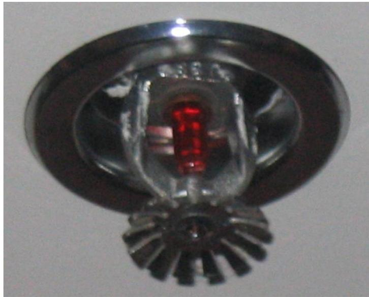
Fig. 3.10 Un rociador central del tipo rebaje
