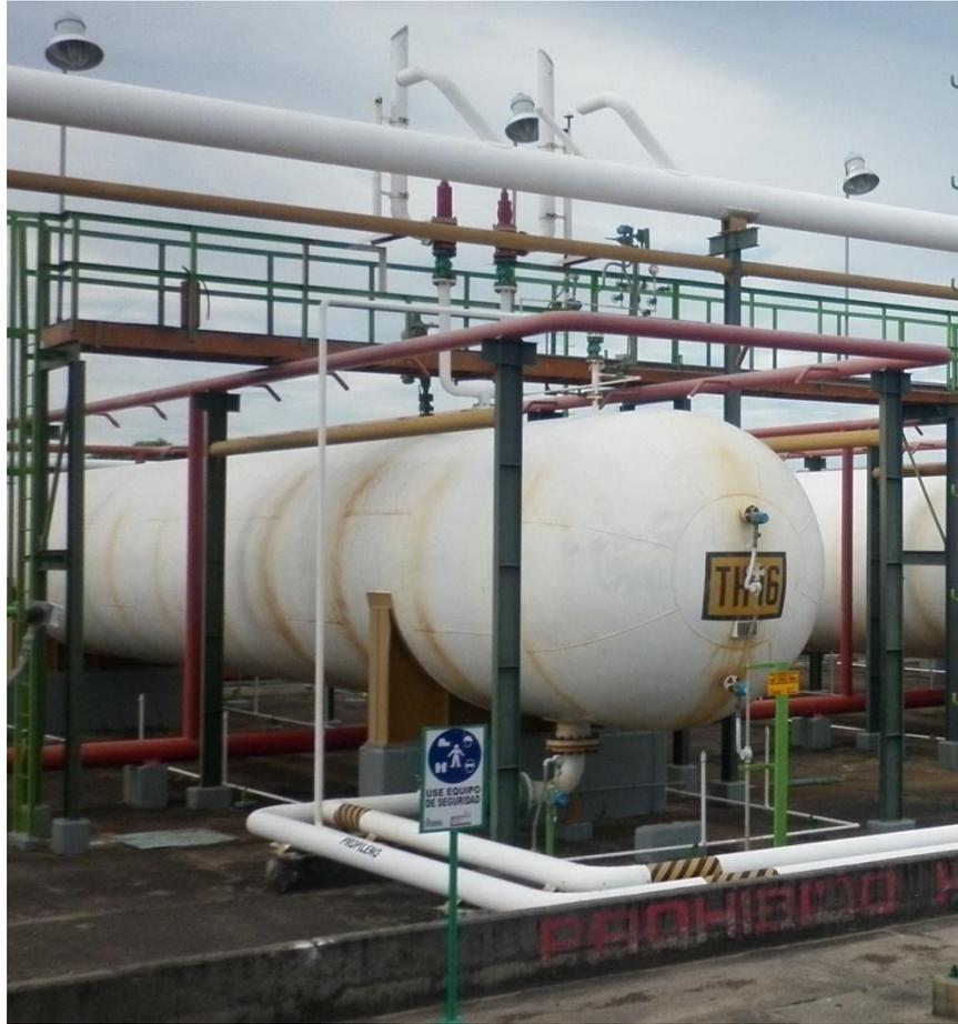
Fig. 7.15 Tanque de almacenamiento de propano.
