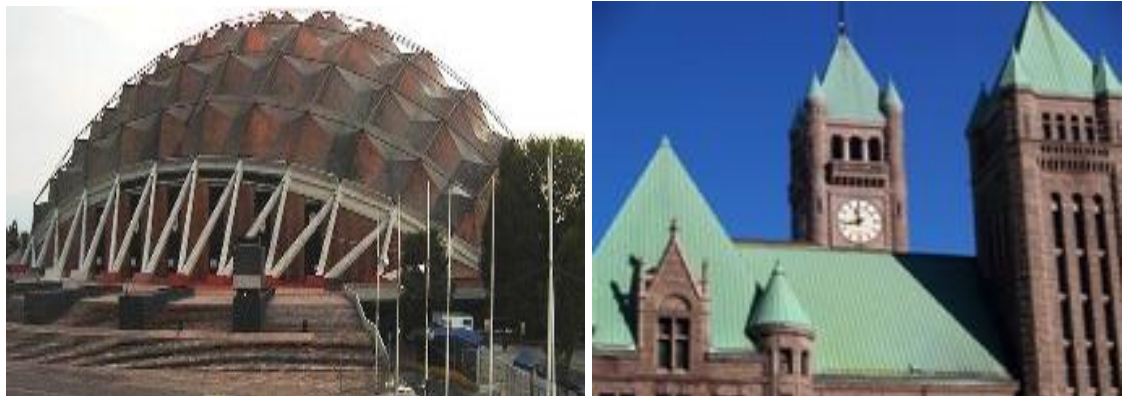
Fig. 3.2. A la derecha se muestra Cubierta del Palacio de los Deportes de México D. F. construida en 1968 con cobre expuesto a la intemperie. Y ala izquierda Techumbre de cobre con pátina de cardenillo en el ayuntamiento de Minneapolis (Minnesota).
