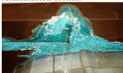
Fig. 3.1 Pátinas cardenillo en el metro de Praga
