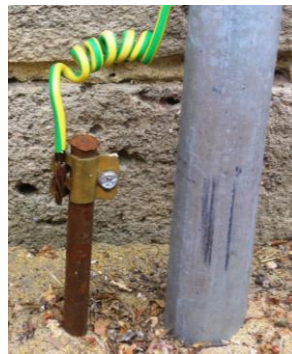
fig.2.18. Conexión a tierra
