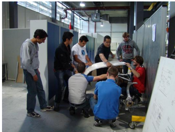
Figura 112. Fijación de las partes de fibra a la estructura metálica
